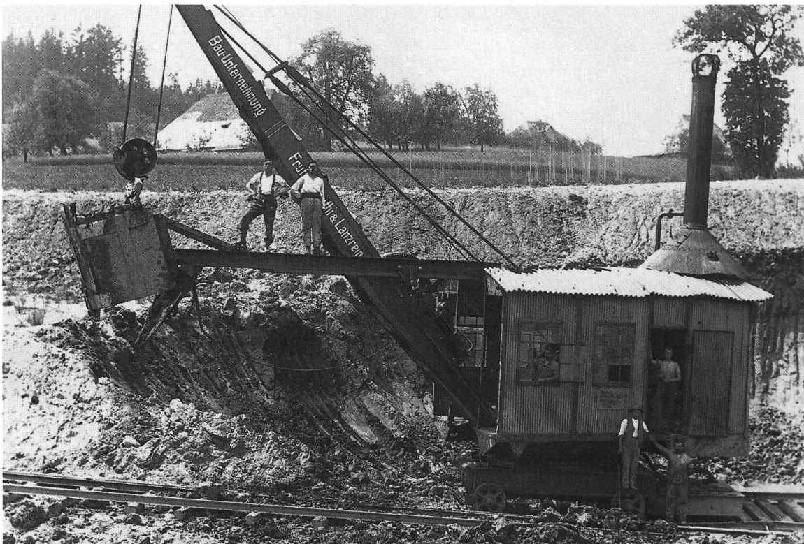
Abb. 17: Der mit Dampf betriebene Bagger in der Grube Gondiswil Haltestelle. Foto: J. Schär, Gondiswil.
