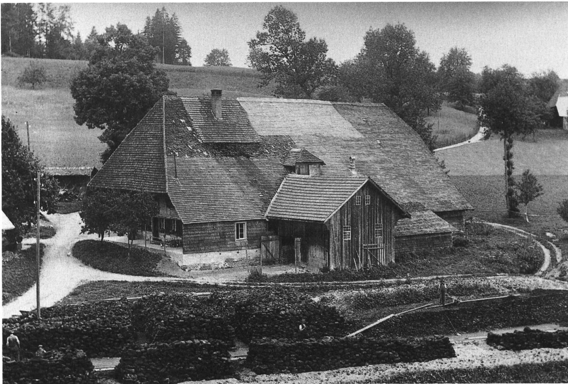
Abb. 13: Zum Trocknen aufgeschichtete Schieferkohlen, sortiert nach unterschiedlicher Grösse. Aufnahme um 1918. Foto: J. Schär, Gondiswil.
