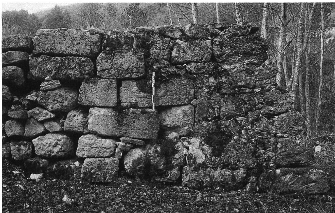
Fig. 13 : Moriez (04) : Éperon nord - face Est. (UA03) (Photographie D. Morin).
