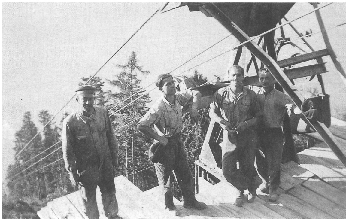
Figure 3: Le minerai de magnétite était descendu par téléphérique au Guercet dans la Plaine du Rhône. La benne est pleine. Léonce Besse (à gauche) et trois internés polonais s'appêtent à l'expédier. Plusieurs dizaines de milliers de tonnes de minerai ont transité par ce téléphérique. (Photo L. Besse).
