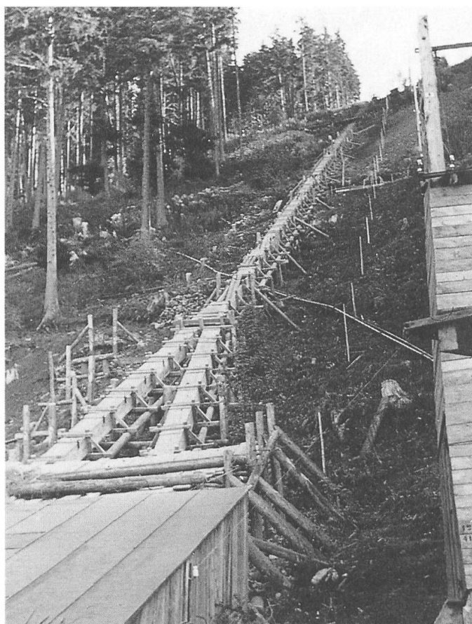
Figure 1: Le fer était extrait par minage au fond de longues galeries, puis acheminé par voies Décauville à l'extérieur jusqu'à une goulotte en bois. Cette goulotte débouchait sur la station supérieure d'un téléphérique.
