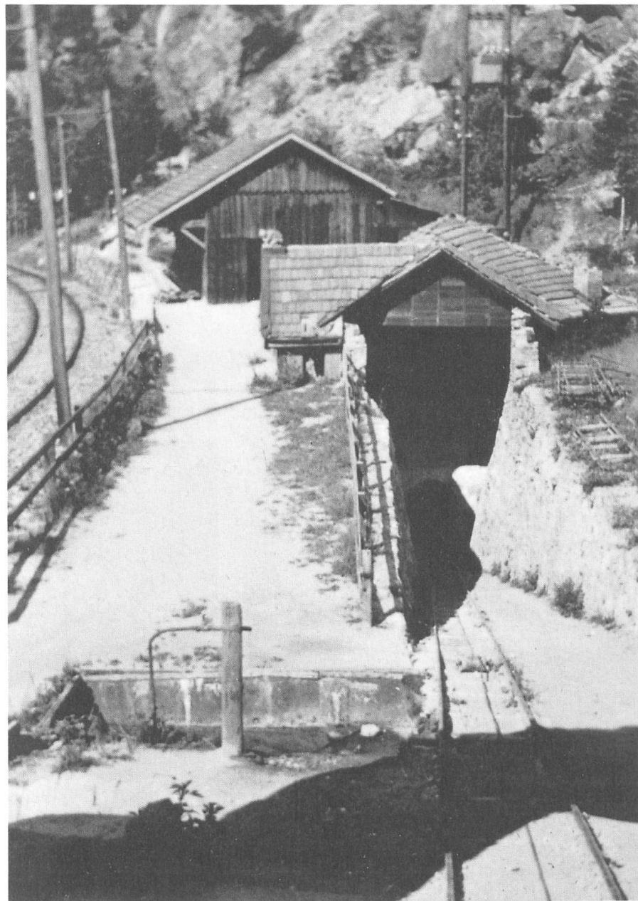
Figure 6: La descenderie permet d'accéder au travers-banc inférieur. Elle est équipée de voies Décauville. Après le tri, le minerai était chargé sur chemin de fer. Un lutin – un Kobold, sur le faîte de la toiture du premier bâtiment – protège les mineurs. (Photo G. de Weisse).
