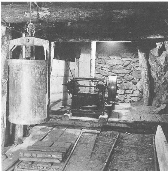
Figure 8: Nous sommes ici au point le plus bas de la mine des Trappistes. Un treuil remonte la fluorine au niveau de la voie Décauville du travers-banc inférieur. Il fallait pomper l'eau en permanence, car cette galerie est plus basse que la Dranse. (Photo G. de Weisse, 1942).
