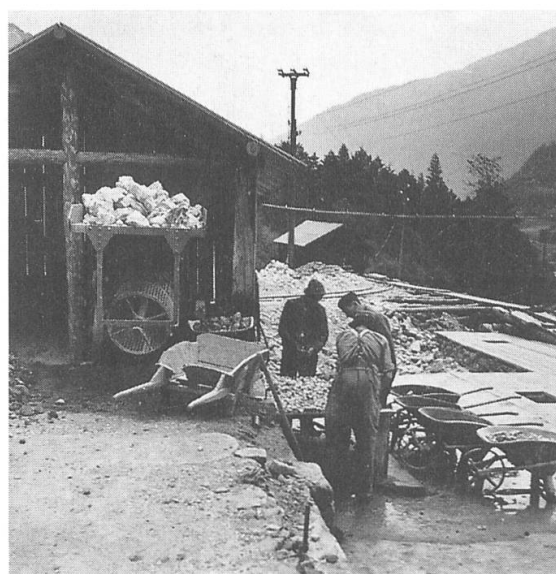
Figure 9: Le tri séparant le quartz et la calcite de la fluorine était manuel. Sur la gauche est installé le concasseur. (Photo G. de Weisse, 1942).
