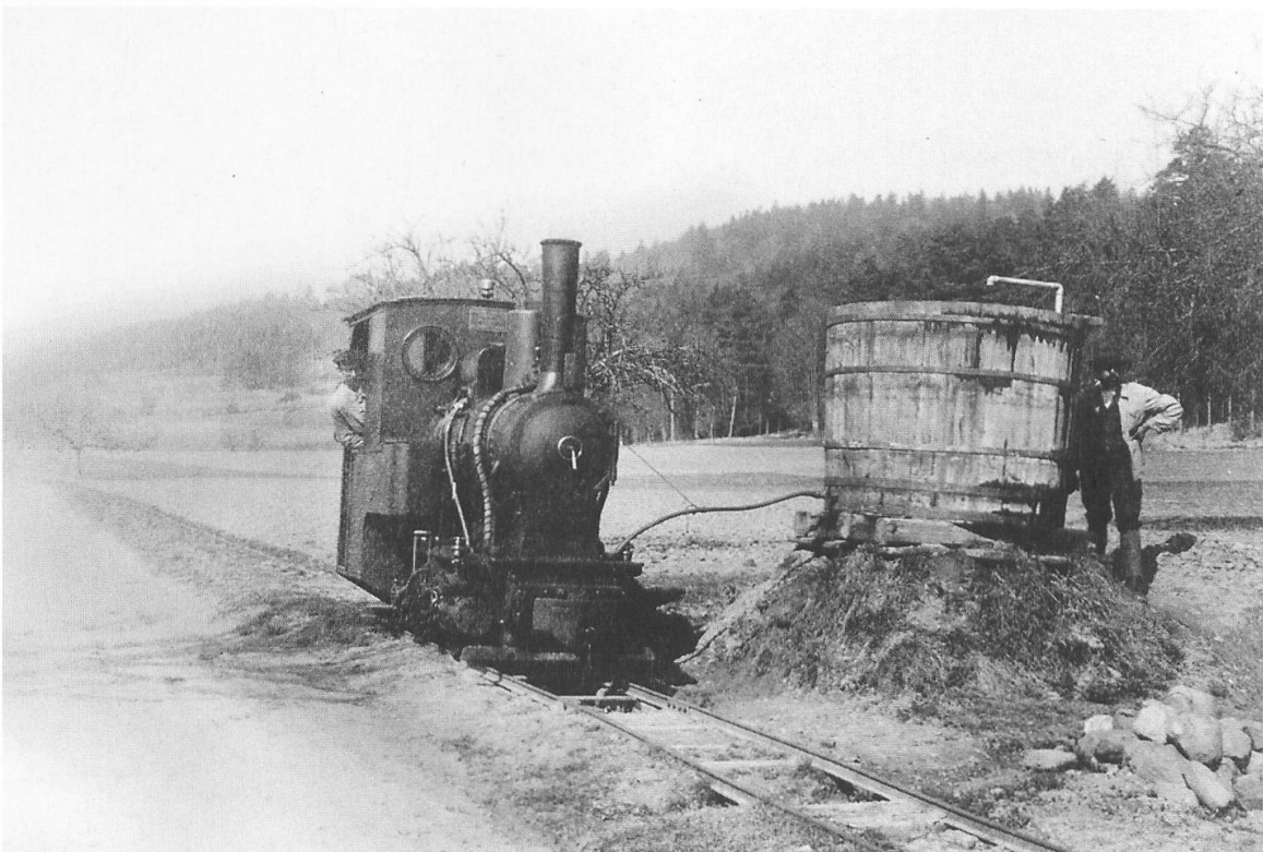
Abb. 14: Wasserspeicher für die Dampflokom beim selbstgebauten Brunnen, der eine Tiefe von ungefähr 2 Meter hatte. Er ist heute noch erhalten. Das Wasser wurde mit einer Handpumpe in den Speichertrog gefördert.
