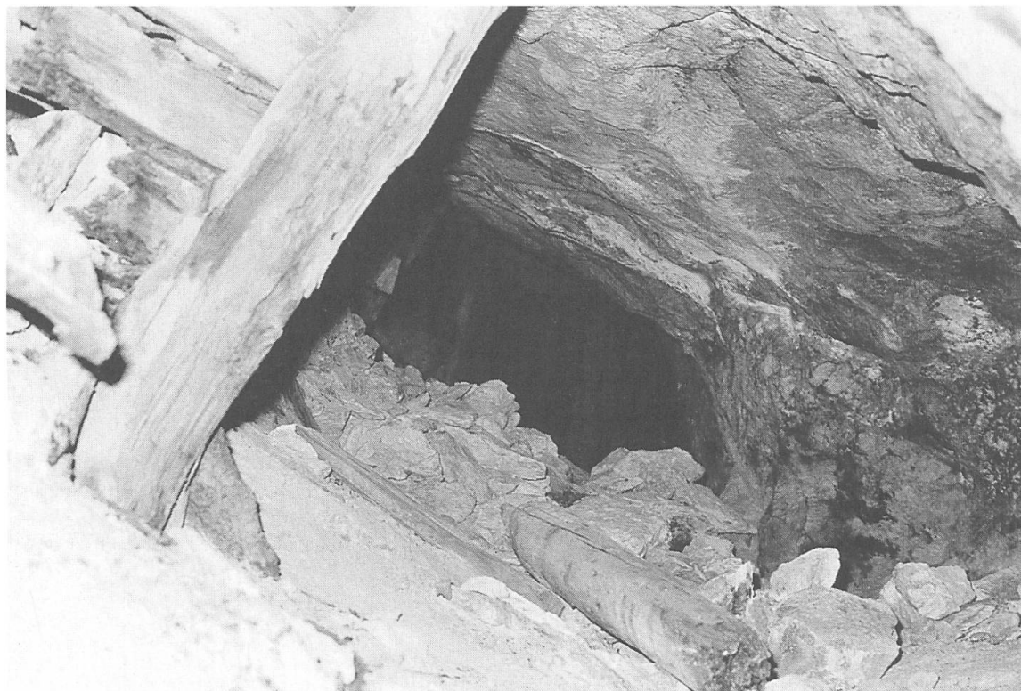
Das Bild zeigt den teilweise eingestürzten Versatz im Hauptabbaugebiet. An einigen Stellen geben die Holzeinbauten dem Bergdruck nach, stellenweise beginnt auch die Decke einzubrechen (Stand 1976).
