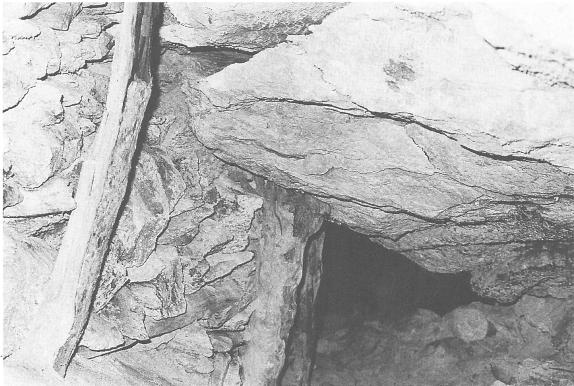
Ein gefährlich von der Decke klaffender «Sargdeckel», notdürftig abgestützt (Aufnahme von 1976). Der stützende Holzträger ist bereits stark beansprucht.
