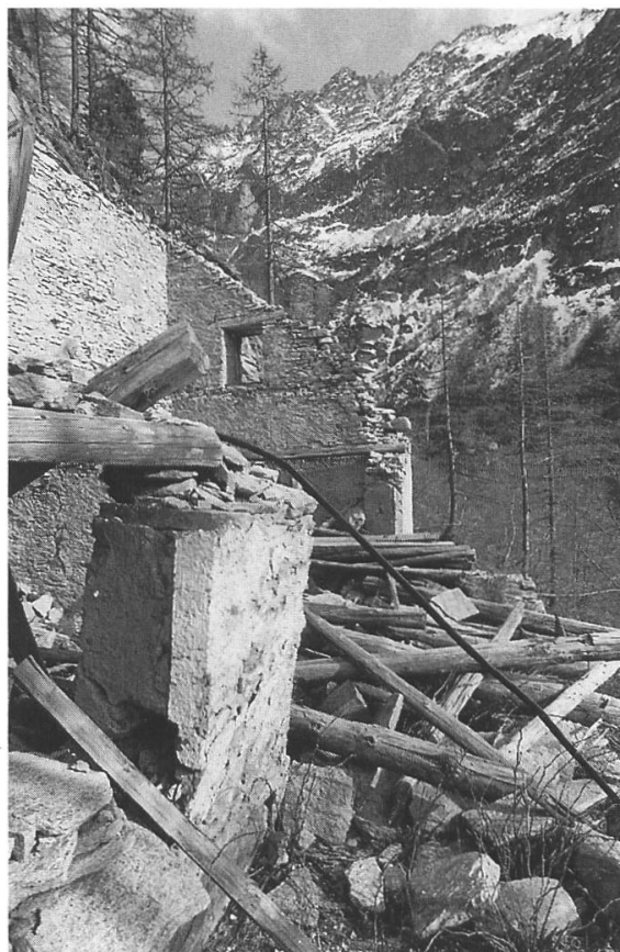
Abb. 24: Camussetta, Gebäude 5 in Blickrichtung Biel-Graben. Foto Hans-Peter Bärtschi, Winterthur, 1995.
