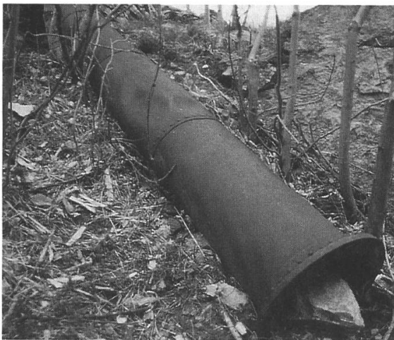
Abb. 21: Von den beiden Druckrohren, die das Wasser den Arrastramühlen zuleiteten, ist eines teilweise erhalten. Foto Hans-Peter Bärtschi, Winterthur, 1995.
