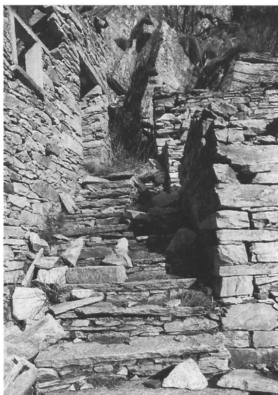
Abb. 27: Treppenaufgang zu den Obergeschossen der Gebäude 2 und 3 auf Camussetta. Foto Hans-Peter Bärtschi, Winterthur, 1995.
