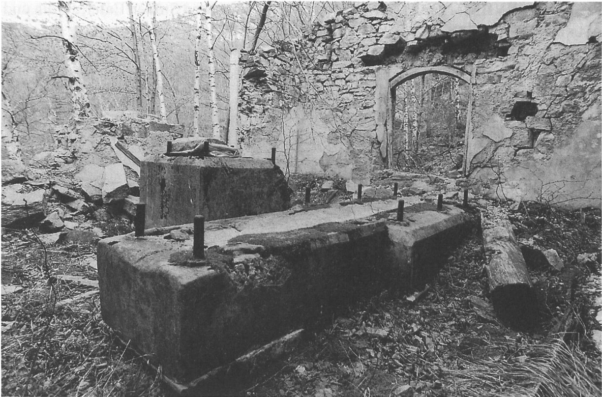
Abb. 33: Krompressorenfundamente im Gebäude vor dem Erbstollen Léopold. Foto Hans-Peter Bärtschi, Winterthur, 1995.
