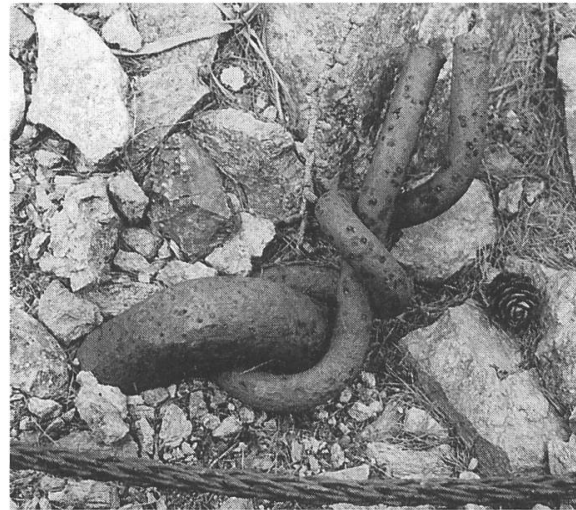
Abb. 45 (Mitte rechts): Drahtseil von 1,5 Zentimeter Durchmesser und schmiedeeiserne Verankerung für die Nebenseilbahn, Station Bruno. Foto Hans-Peter Bärtschi, Winterthur, 1995.
