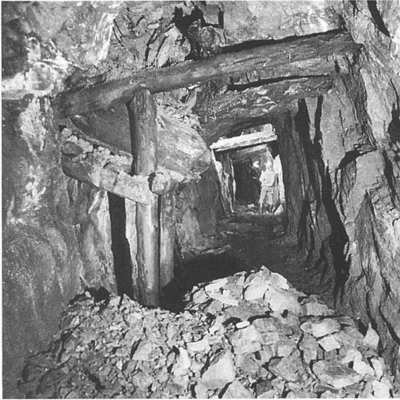
Abb. 28: Camussetta, Abbauggebiet XVII mit Verladestation. Foto Hans-Peter Bärtschi, Winterthur, 1995.
