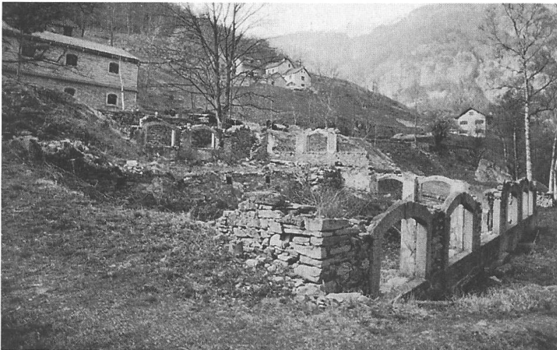
Abb. 17: Von der Aufbereitung 2 Frue Vanners sind Teile der im regionalen Stil sorgfältig gestalteten Stichbogenfassaden erhalten. Foto Hans-Peter Bärtschi, Winterthur, 1995.
