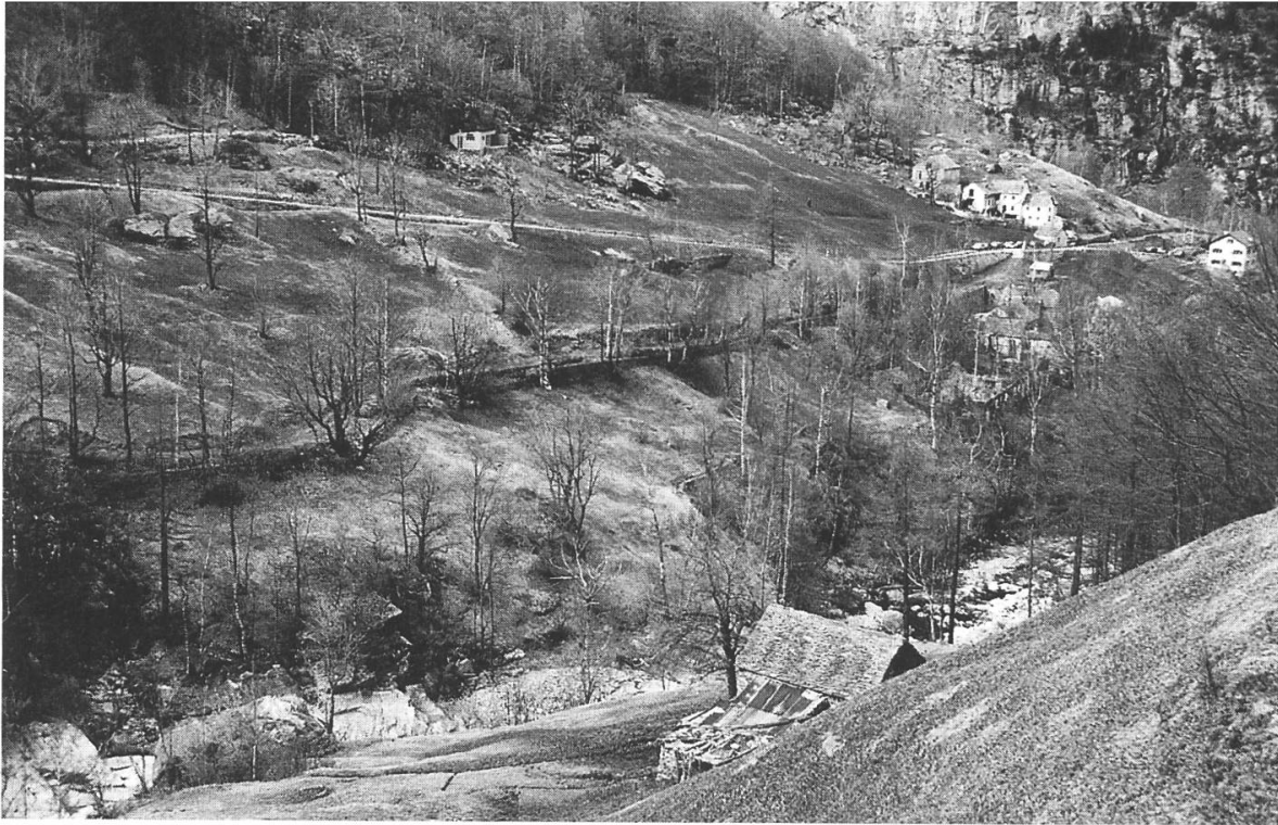
Abb. 20: Deutlich hebt sich die Stützmauer des Oberwasserkanals als künstlicher Eingriff in die Hanglehne oberhalb des Minenbodens ab. Foto Hans-Peter Bärtschi, Winterthur, 1995.
