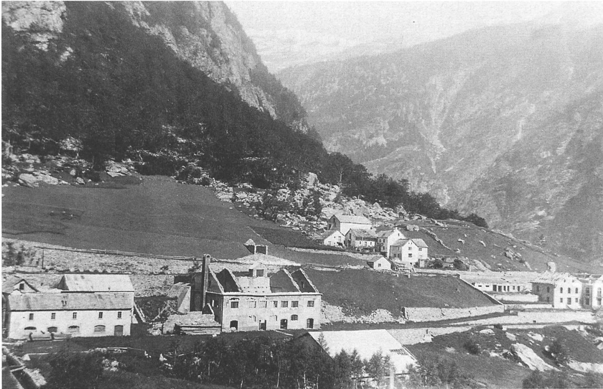
Abb. 7: Älteste bekannte Foto der «Usines Minenboden», 1920er Jahre. Bei der Villa (rechts) und bei der Erzstampfanlage fehlten ein Vierteljahrhundert nach der Betriebseinstellung bereits die Dächer, die Anlage Frue Vanners (unten) war noch vollständig gedeckt.
