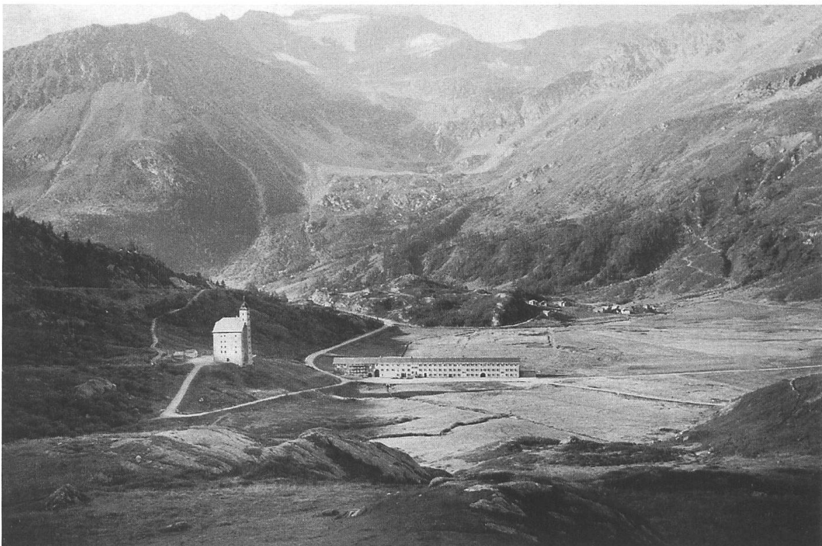
Abb. 8: Die Ebene von Gampisch südlich des Simplonpasses: Am Rande der nach der Eiszeit aufgeschütteten Ebene entstanden die Alpsiedlung Gampisch (rechts), der «Alte Spittel» und das Barralhaus. Das turmartige Hospizgebäude wurde von Kaspar Jodok von Stockalper anstelle eines älteren Hospizes errichtet und 1666 vollendet. Das langgestreckte Barralhaus entstand zu Beginn unseres Jahrhunderts und dient heute der «Gesellschaft des Missionshauses Bethlehem» (Immensee, SZ) als Ferien- und Seminargebäude. Foto Klaus Anderegg.
