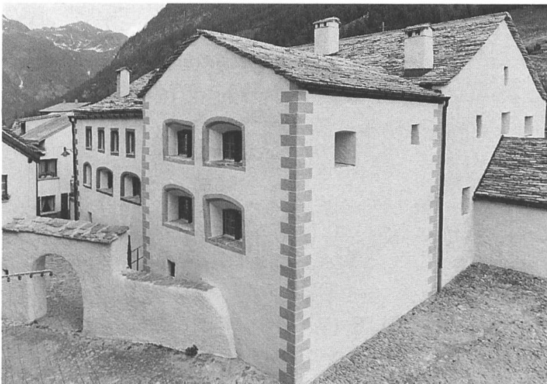
Abb. 10: «Alter Gasthof» in Simplon-Dorf: Das Sustengebäude auf dem Dorfplatz von Simplon ist in mehreren Bauetappen seit 1325 entstanden. Es enthält das Museums- und Betriebszentrum des Ecomuseums Simplon und die Gemeindeganzlei von Simplon-Dorf. Foto Hans-Peter Bärtschi.
