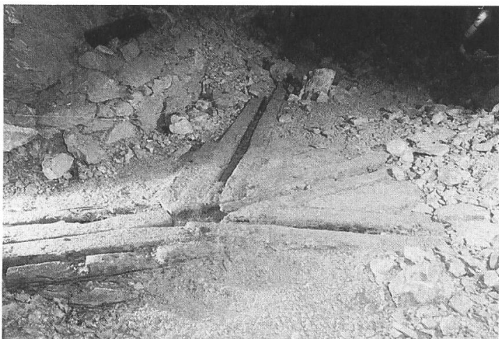
Spurnagelweiche in einem alten Stollen auf Mot Madlain. Foto: Hans-Peter Stolz.
