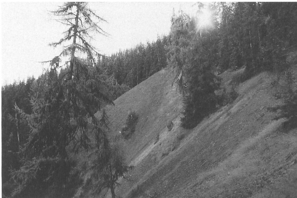
Fig. 3. Vue générale des déblais des travaux Est de la mine de Peiloz, prise le 3 novembre 1995.
