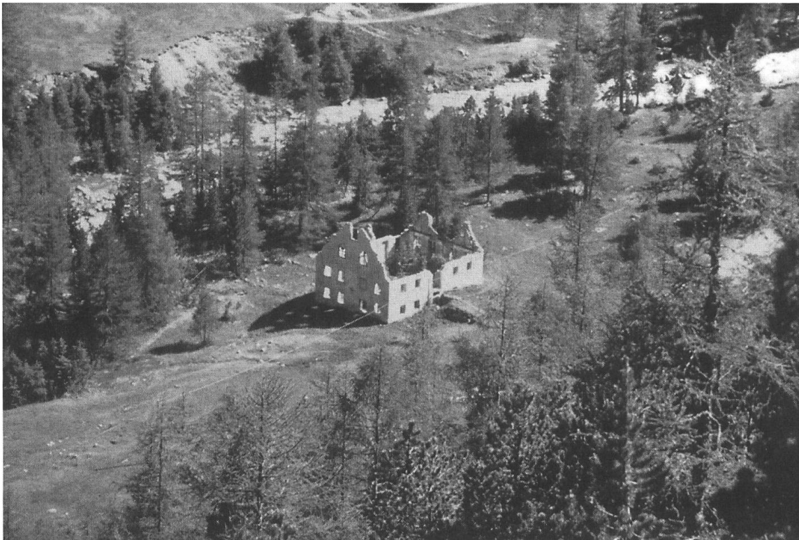
S-charl, Schmelzra. Ruine des Verwaltungsgebäudes. Foto: H.P. Bärtschi.
