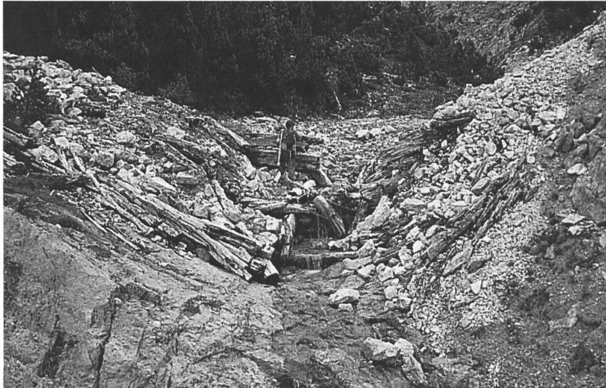
Reste der Triftklaus Val Chaschabella. Mit Hilfe solcher Schwellen wurden die kleineren Gebirgsbäche gestaut. Durch das Öffnen der Triftklausen wurden die ins Bachbett geworfenen Hölzer talauswärts geschwemmt. Die Hölzer wurden zuvor auf bis zu drei Fuss Länge zugeschnitten. Foto: Jon Domenic Parolini.
