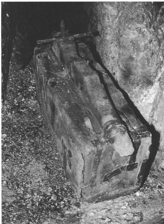
Umgestürzter Grubenhund (Mittelachse und Räder fehlen) mit welchem der Erztransport in den Hauptstollen erfolgte. Erkennbar Förderachse und Spurnagel. Foto: M. Schreiber.
