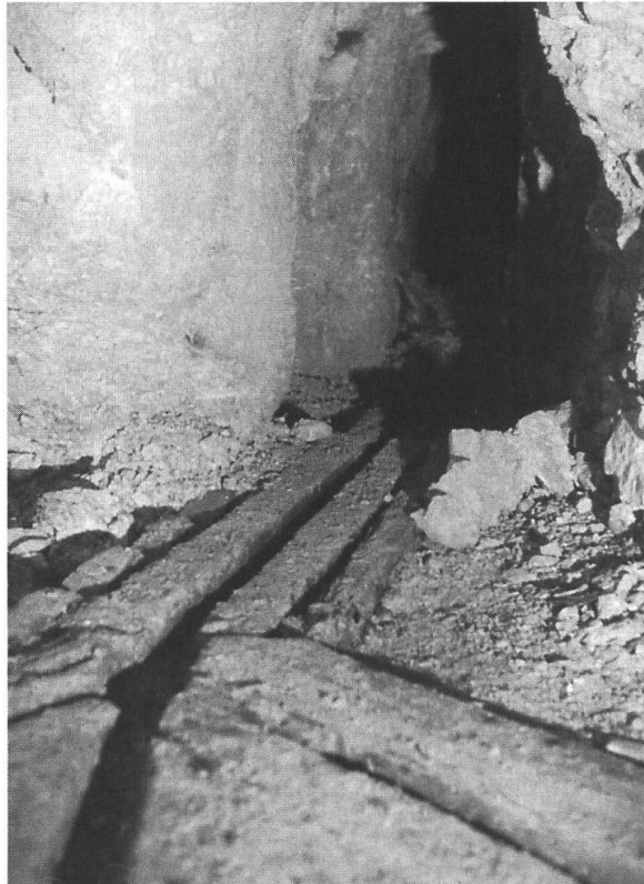
Spurnagelweiche im Labyrinth-Bereich zwischen den mittelalterlichen Stollen und dem Abbau um 1820. Foto: H.P. Bärtschi.
