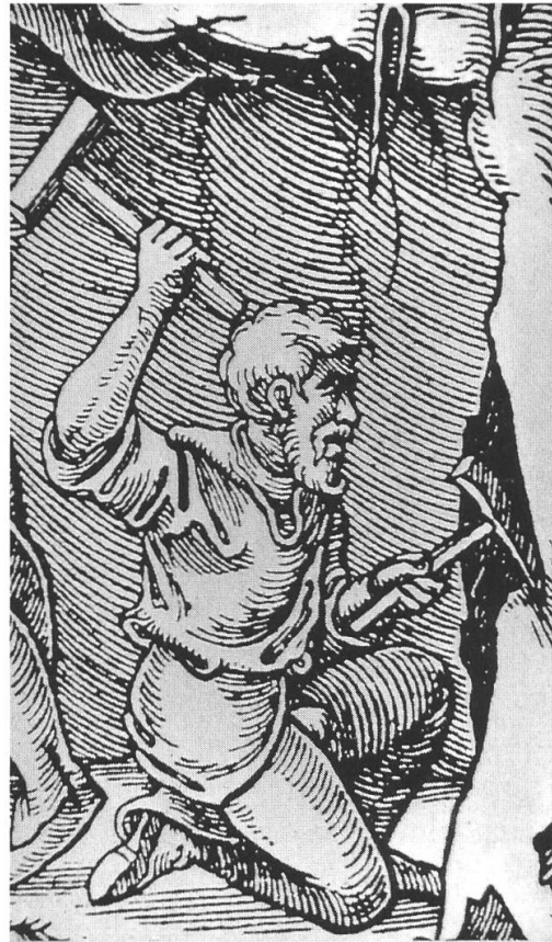
Stollenvortrieb mit Hammer und Bergeisen, nach Agricola, um 1550.
