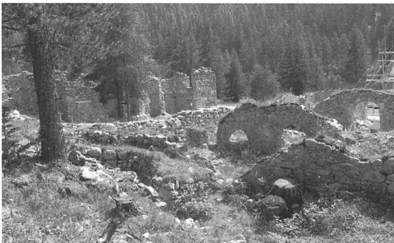
Ruinen der Schmelzra von S-charl. Im Hintergrund das Verwaltungsgebäude während der Sanierung. (Foto E. Brun)
