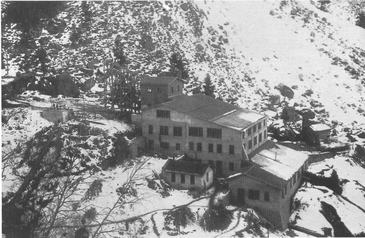
"Die Aufbereitung vom Martinsgraben aus gesehen"
