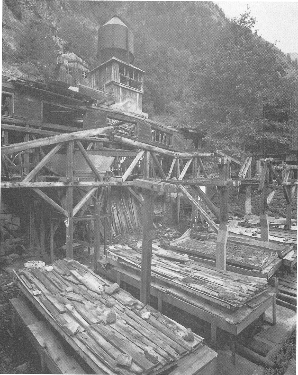
Blick über die Aufbereitung "Dionisotti". Im Vordergrund die (zugedeckten) Schütteltische.
