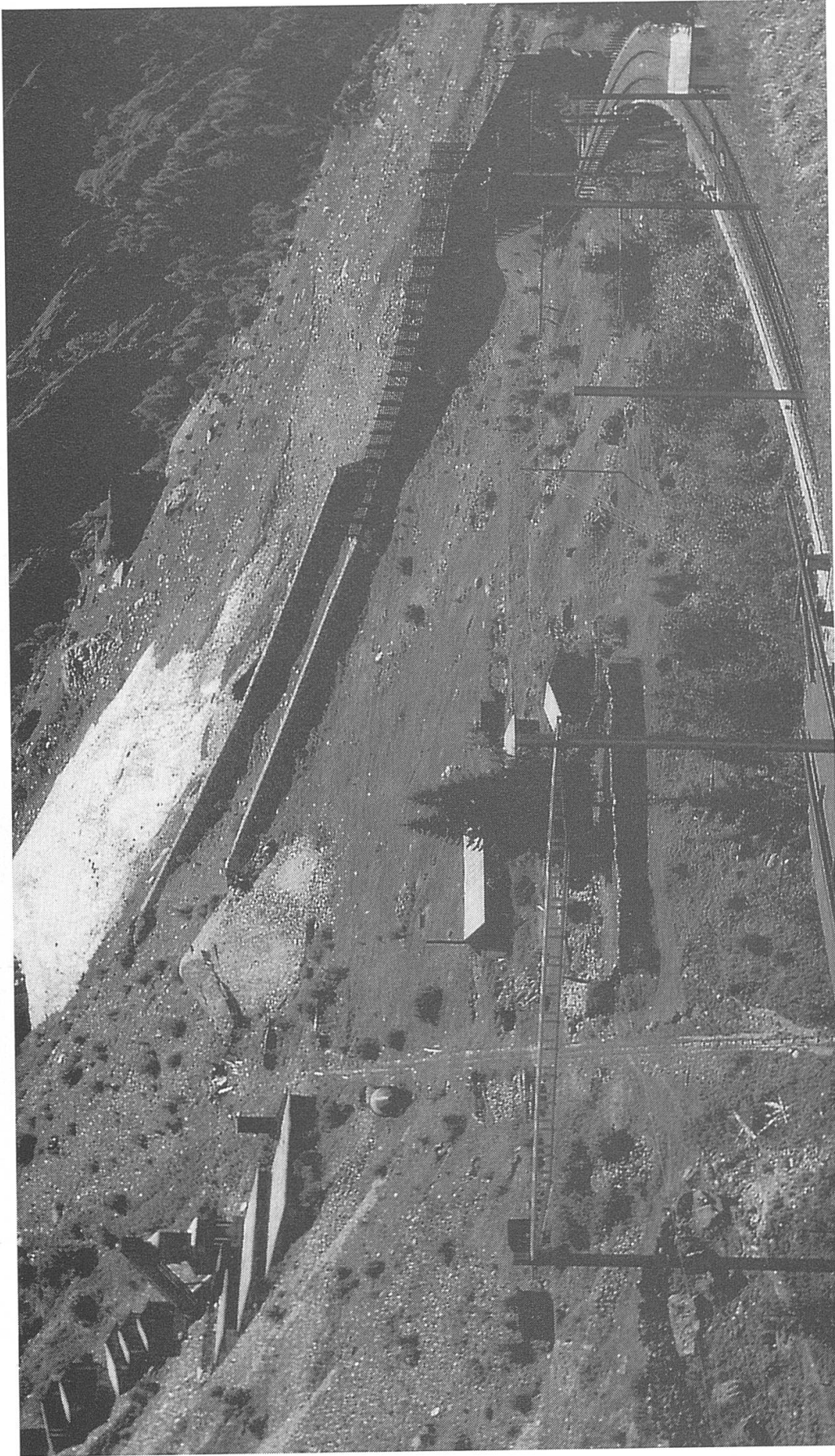
Übersicht "Rote Matte": Neben dem Friedhof die Kantine, Unterkuftsgebäude und Büros des Bergwerkes, Trasse des Aufzuges von der Talstrasse zur Aufbereitung, rechts davon die Talstation der Seilbahn (eine einfache Umlenckrolle) mit Fördergut aus den Stollen 1820 m und 1860 m., links die neue Aufbereitung. Foto Willy Haas, um 1960.
