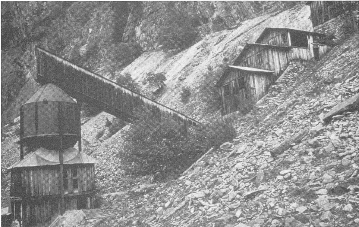
Erste Schäden werden sichtbar, Foto Rolf Eichin, um 1972.
