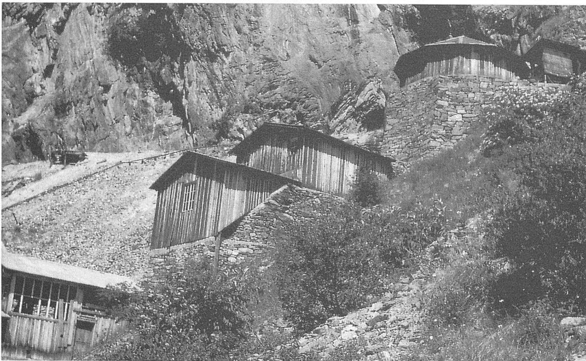
Die oberen Gebäude mit den Steinbrechern. Links der obersten Baracke ist der Eingang in die Kaverne sichtbar, rechts schützt ein Bretterschlag die Winde des Aufzuges. Fotos Willy Haas, um 1960.
