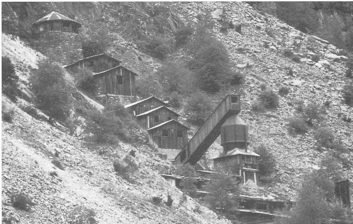
Die letzte Zeit im Ursprungszustand. Gesamtansicht der Erzaufbereitung "Dionisotti" im Jahre 1975. Foto Andreas Burkhard, 1975.
