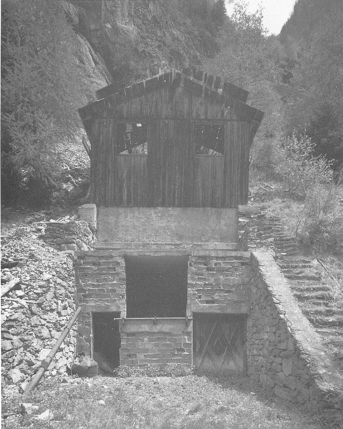
Blinde Fenster. Die oberen Gebäude der Aufbereitung "Dionisotti" beherbergen die Steinbrecher.
