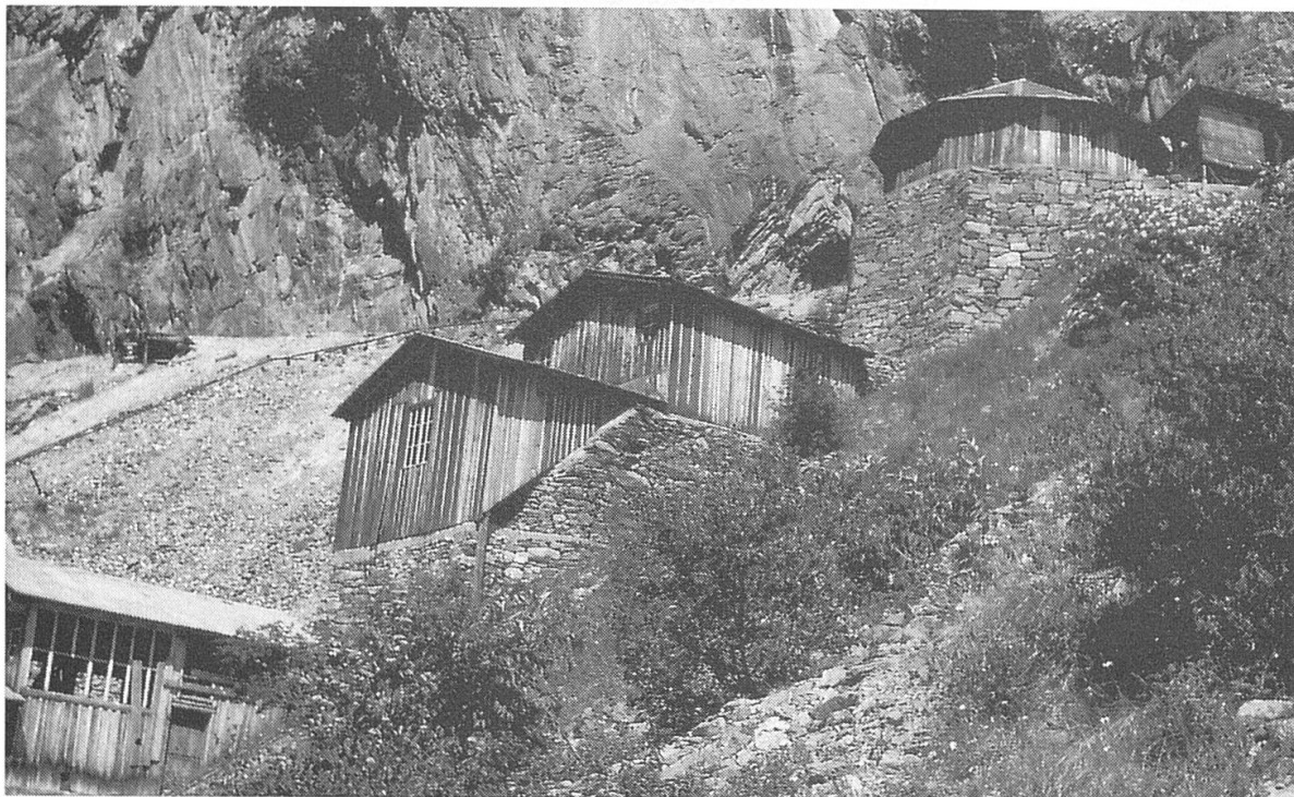
Die oberen Gebäude mit den Steinbrechern. Links der obersten Baracke ist der Eingang in die Kaverne sichtbar, rechts schützt ein Brettverschluss die Winde des Aufzuges. Fotos Willy Haas, um 1960.
