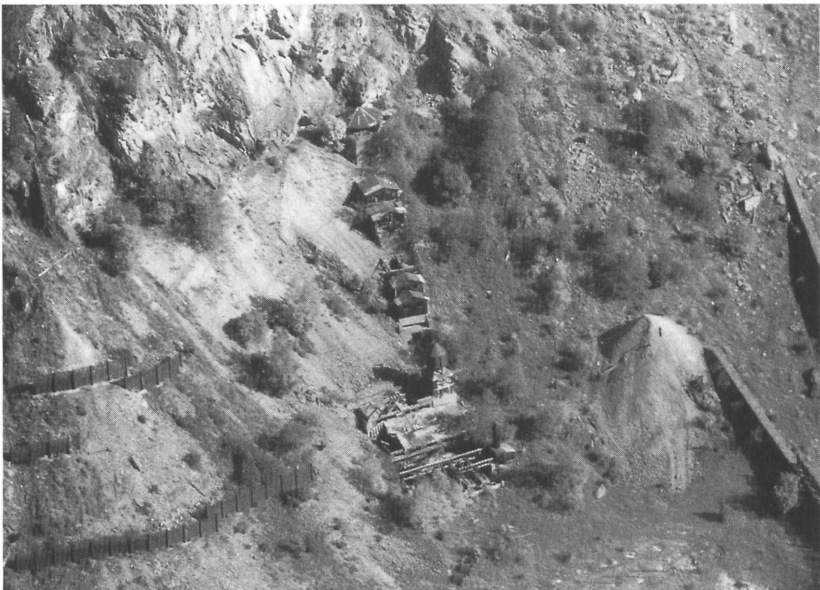
Die Aufbereitung Dionisotti auf der sogen. Roten Matte bei Goppenstein. Rechts der Aufbereitung die Talstation der Seilbahn und das Fördergut aus den Stollen 1820 und 1860 m. Foto Werner Bellwald und Hans Kalbermatten, 1983.
