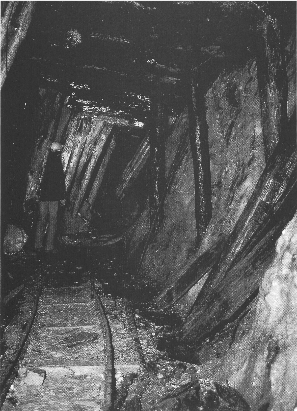
Auf Niveau 1820 lässt Dionisotti nicht nur eine Seilbahnstation errichten, sondern auch Stollen bis zu 300 m tief in den Berg treiben (Foto W.B. und Albin Bachmann, 1983).
