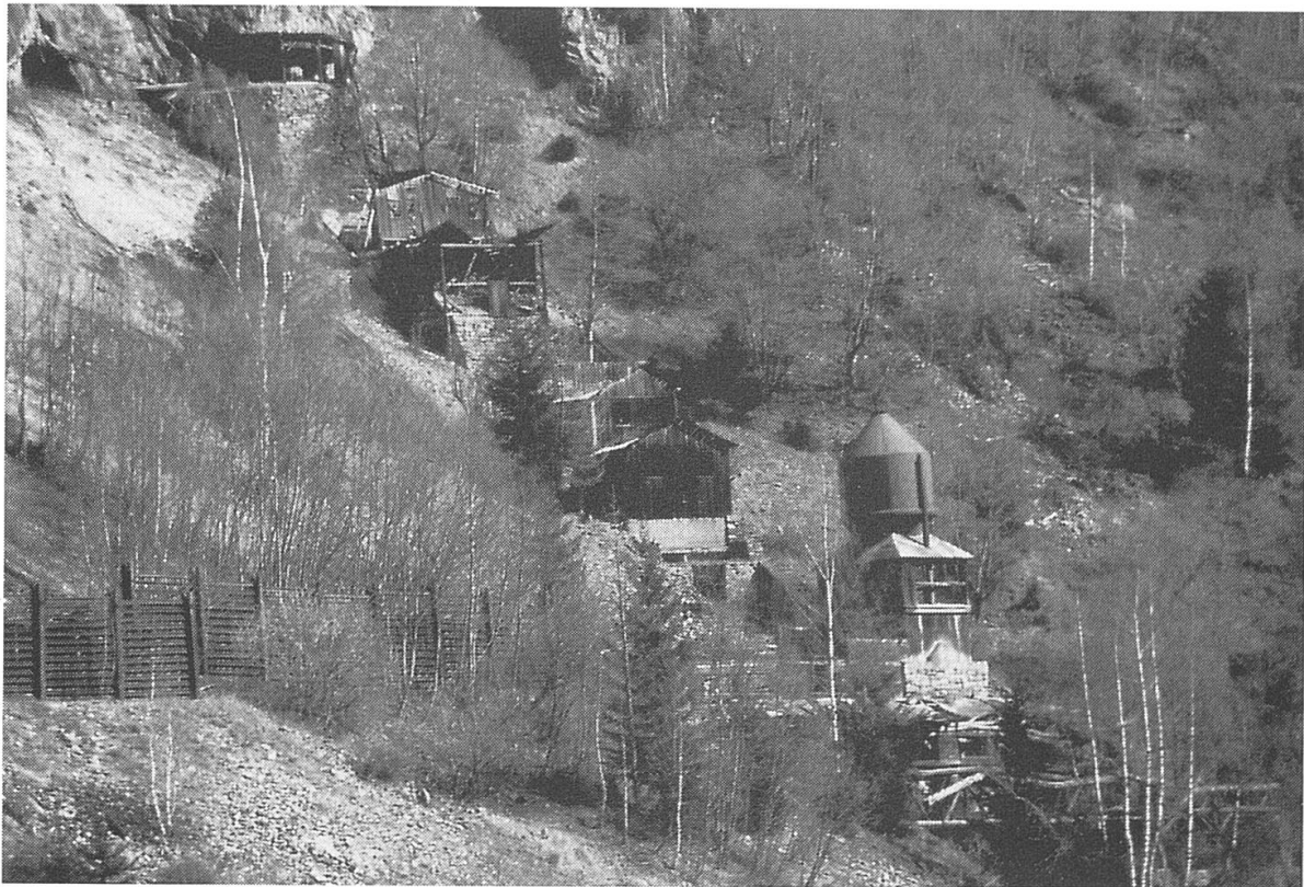
Die Erzaufbereitungsanlage Goppenstein heute. Das Skelett der Anlage wird sichtbar (Foto A.B. 1994).
