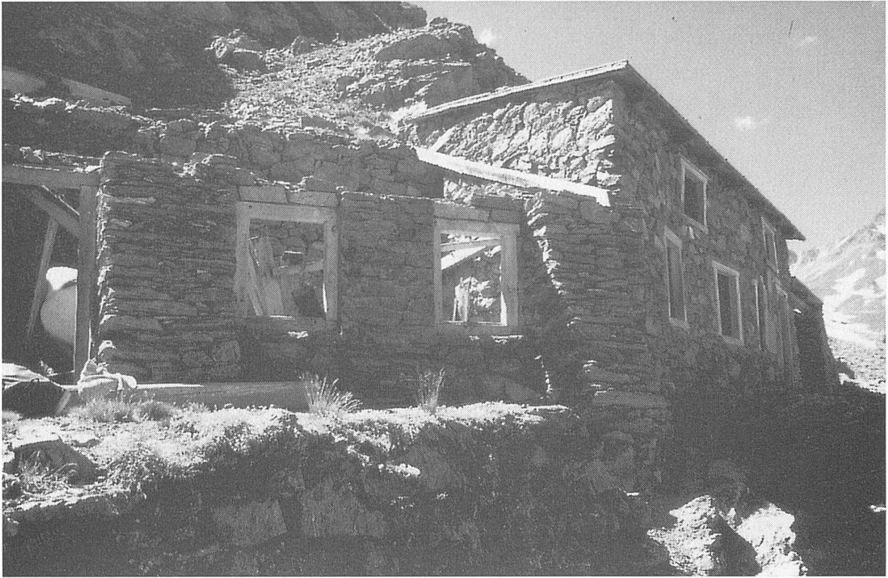
Nickel-Kobaltbergwerk Kaltenberg im Turtmantal (2500 m. ü. M.). Zustand 1978 (Foto A.B.).
