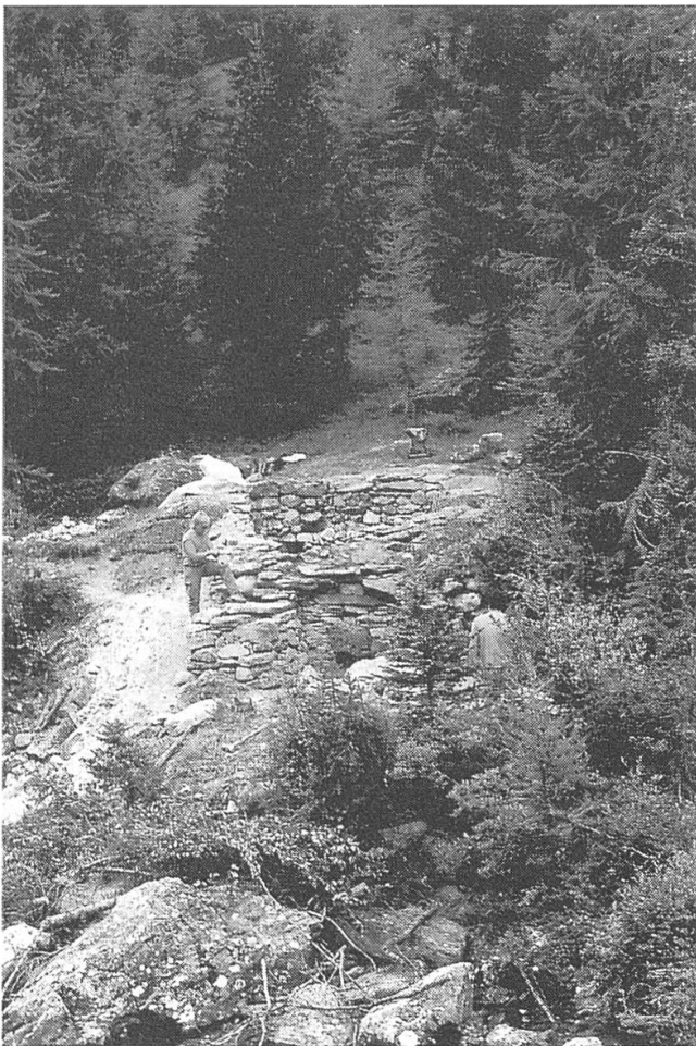
Fig. 3. Restaurierung des Kalkofens am Messerbach kurz vor der Vollendung (12. Sept. 1991). Über genau diese Stelle fegte im Frühjahr 1994 eine gewaltige Lawine hinweg: sämtliche Bäume und Büsche wurden abrasiert - der Kalkofen blieb unversehrt! (Foto SG)
