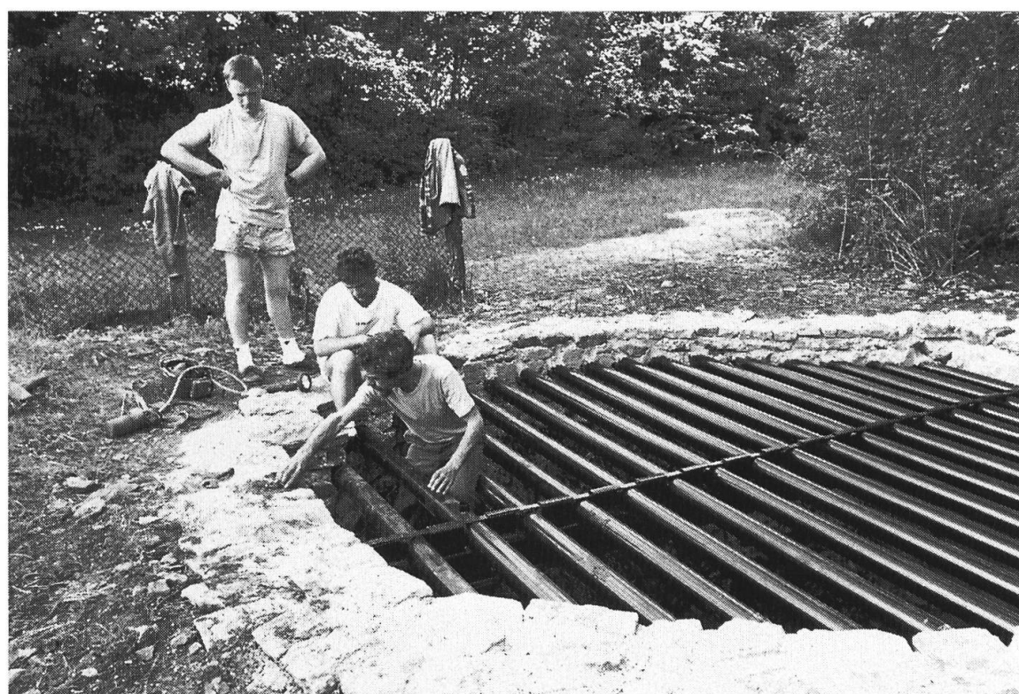
Fig. 8: Mine des Equevillons. Pose de la grille de protection. Puits d'entrée.
