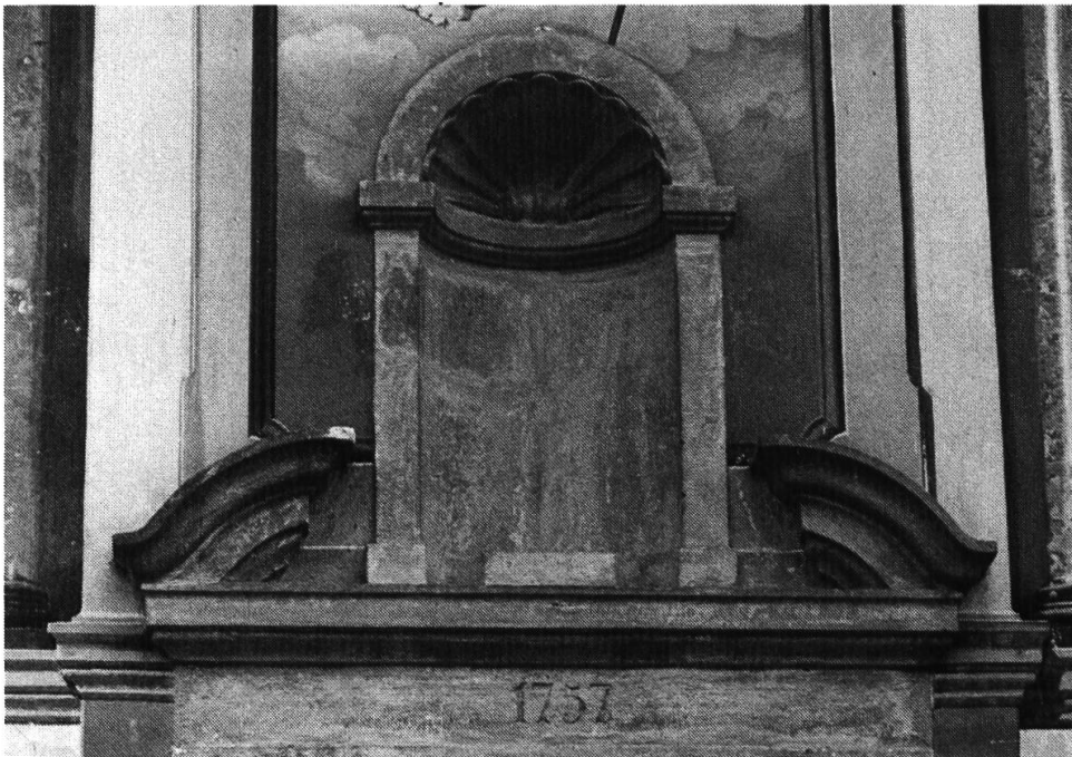
Fig. 13 Ornement en pierre ollaire (ici probablement un chloritoschiste) de 1757 au dessus de la porte principale de l'église de Pedemonte, Alagna.
