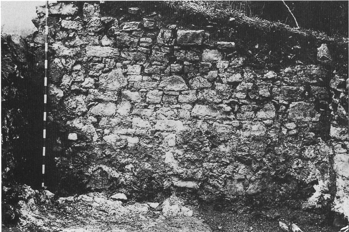
Abb. 7 Westmauer mit Resten des Lehmverstrichs, von innen gesehen Befundzustand 1948 (Aargauische Kantonsarchäologie)
