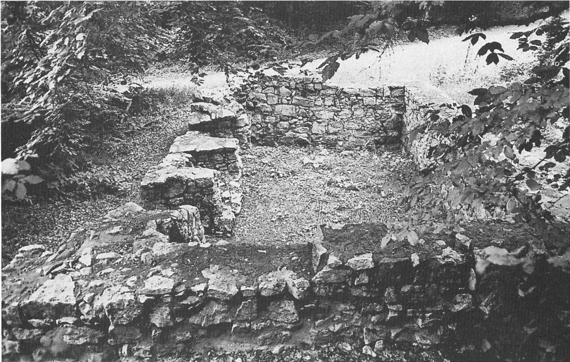
Abb. 3 Ansicht des Röststadels von Westen, heutiger Zustand (Verfasser)
