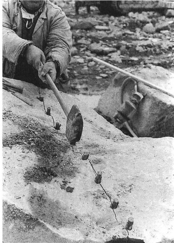
Trennen eines Sandsteinblockes durch Stahlkeile, die in die vorgebohrten Löcher eingetrieben werden.
