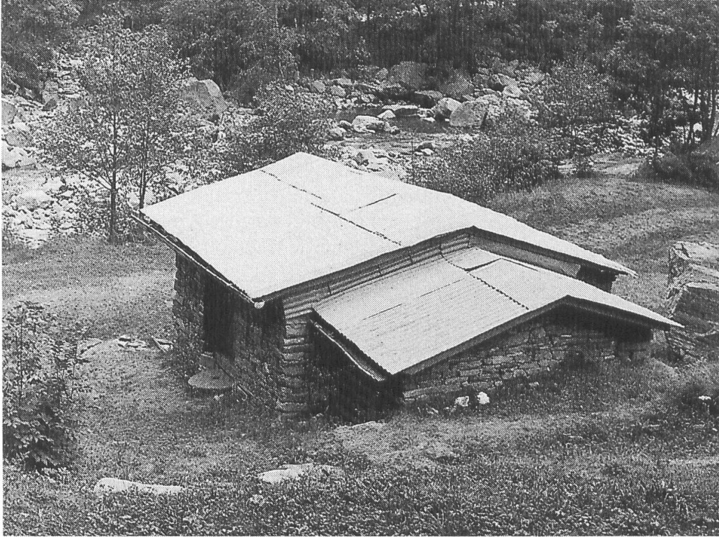
Abb. 2.6: Heutiger Zustand der ehemaligen Drehwerkstätte von Cauco, Val Calanca (Blick gegen Südwesten). Im Hintergrund der Fluss Calancasca. Beim Eingang links wurden ein Mühlstein und halbierte Kerne einer Topfserie als Schwelenelemente verwendet.
