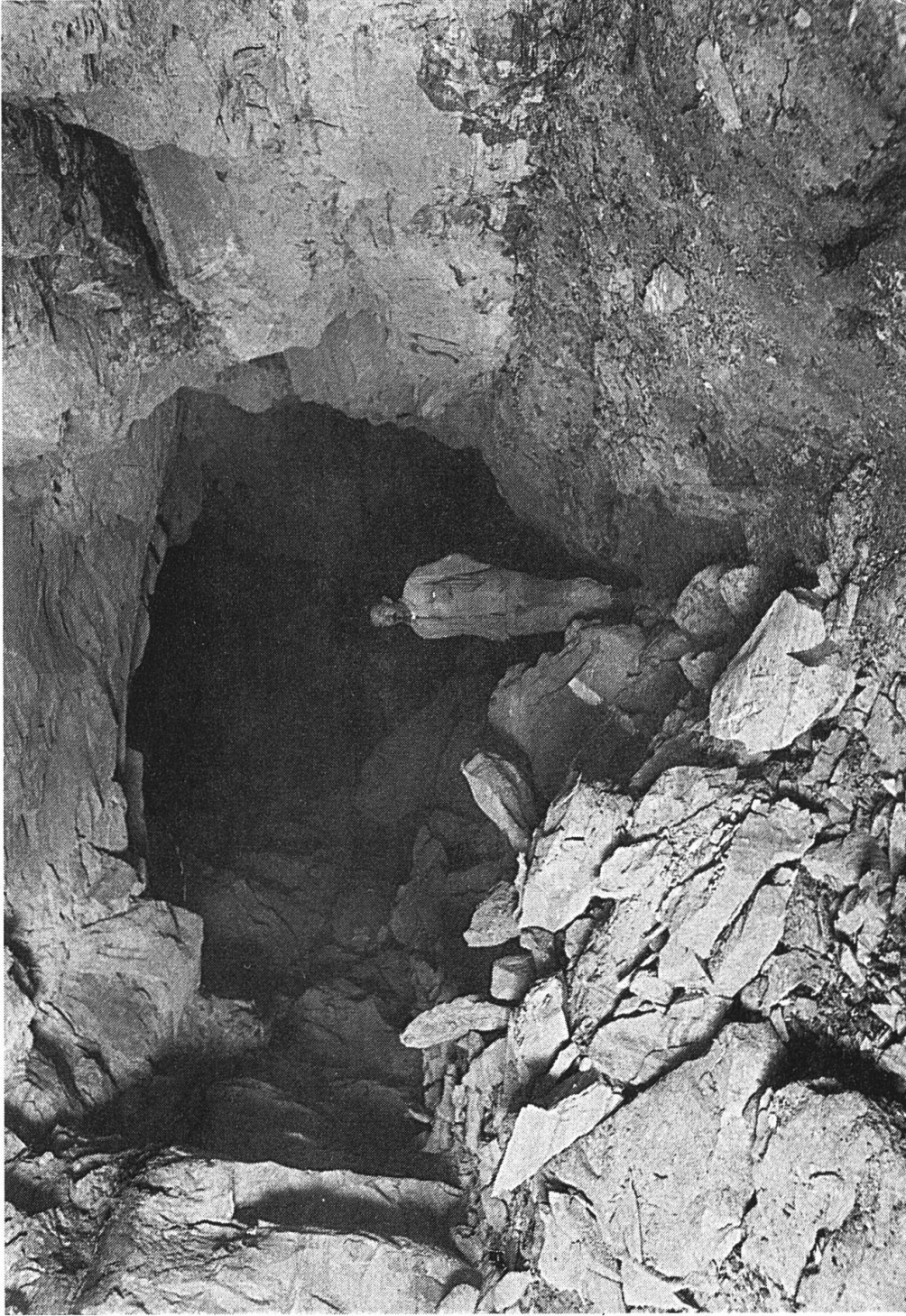
Gewaltiger Stollen im Bereich Gwandlen, 1946 (Foto: Tiefbauamt Zürich)
