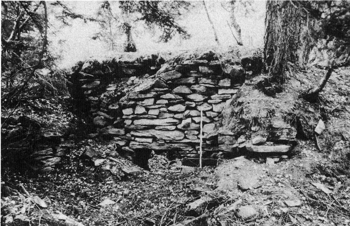
Fig. 3 Kalkofen hinter der Biela oberhalb Ausserberg mit rundgemauelter Feuerkammer und Schürloch. Messbalken 1m.
