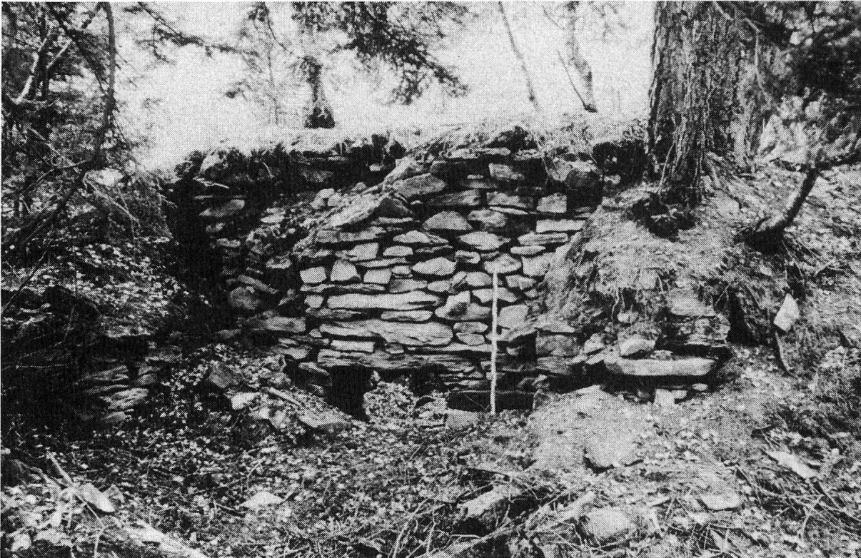
Fig. 3 Kalkofen hinter der Biela oberhalb Ausserberg mit rundgemauerter Feuerkammer und Schürloch. Messbalken 1m.
