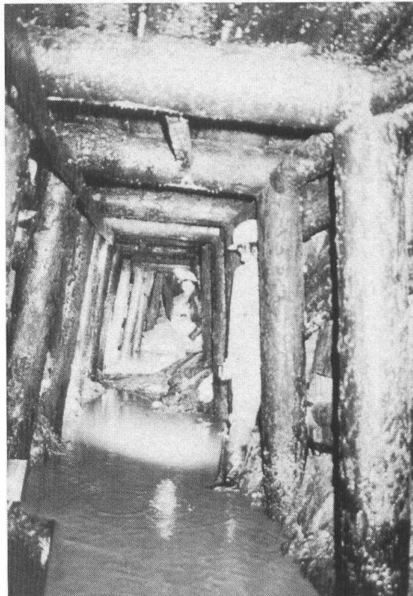
Förderstrecke des Zweiten Weltkrieges mit morscher Holzverkleidung. Foto L. Schmutz, 1980.
