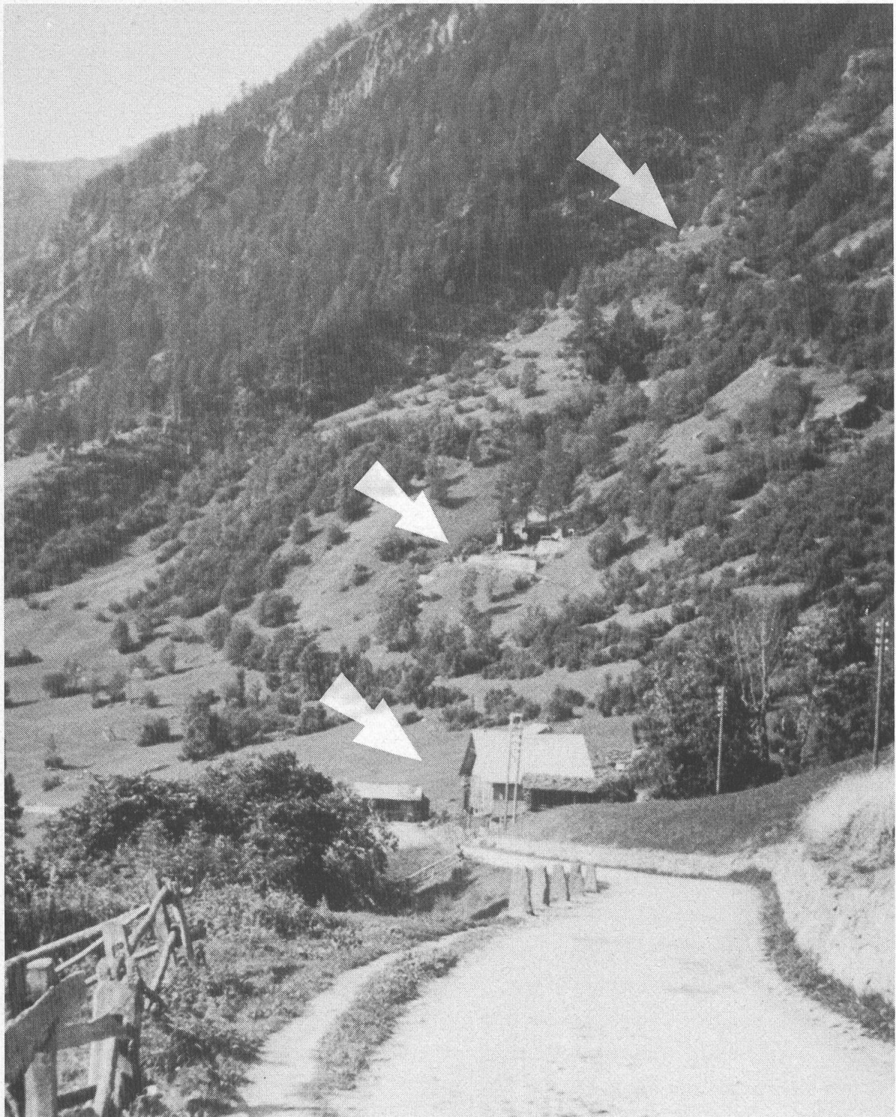
Das Minengebiet von Norden: Oben die Stollen des Ersten Weltkrieges, in der Mitte die Stollen 1940 - 48, unten die Anlagen Goltschenried. Foto Prior Siegen, 1940.
