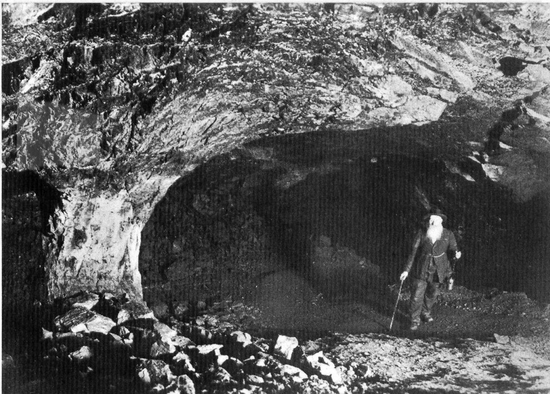
Bild 5: Alter Abbau in Grube I. Erzpfeiler und Dach gewölbeartig infolge Feuersetzen.
