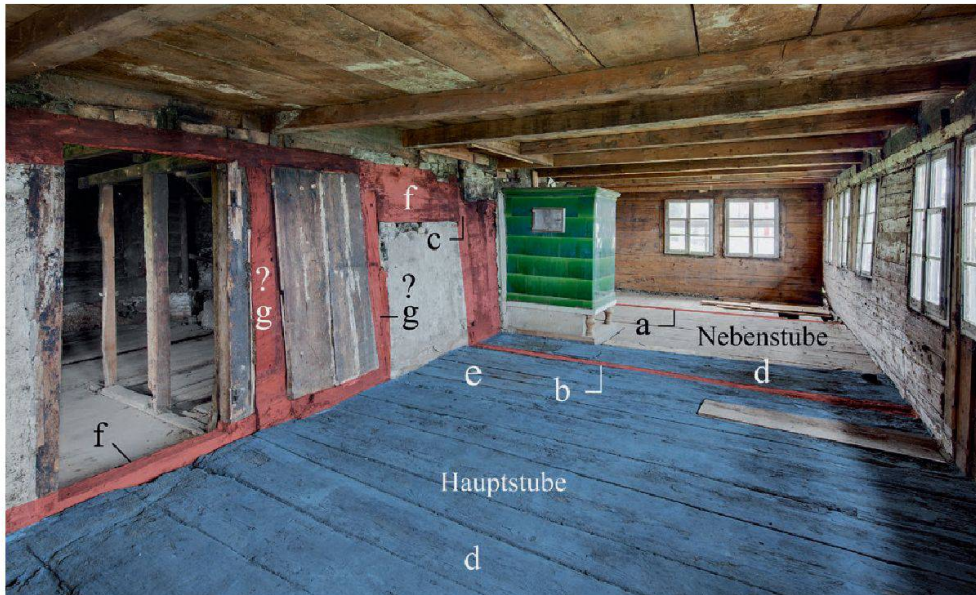
Abb. 6: Haupt- und Nebenzube, Blick gegen Nordosten: Ostfassade (abgearbeiteter Schwellbalken) des Gründungsbaus (a), abgearbeiteter Schwellbalken der Binnenwand (b) sowie Nut (c) im Originalgefüge (f), die 1557 dendrodatierten Fussbodenbohlen (d), Standspur eines Kachelofens (e) und vermutlich originale Mantelstube (g).
