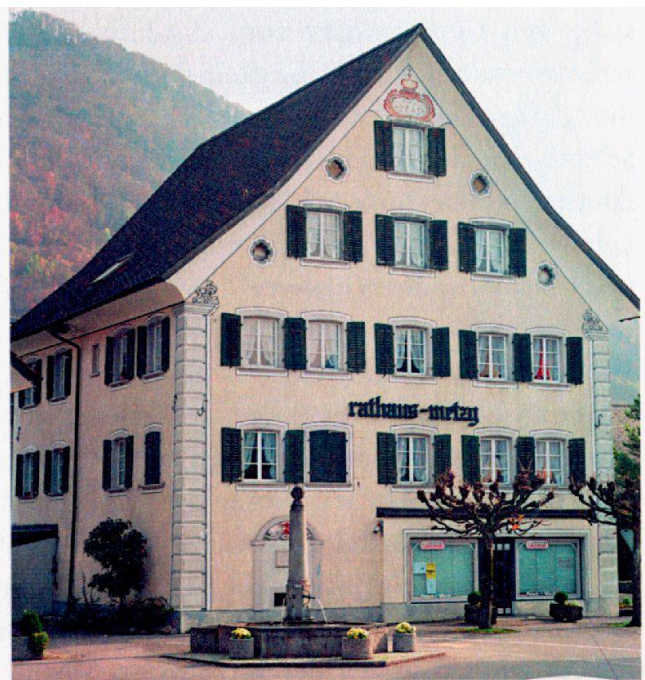
Abb. 11: Das Rathaus Schänis war in Früher Neuzeit Sitz der Verwaltung des Landes Gaster und Wohnung des Landweibels. Es wurde 1613 nach dem Dorfbrand neu erstellt und zuletzt 1937 umgestaltet.
