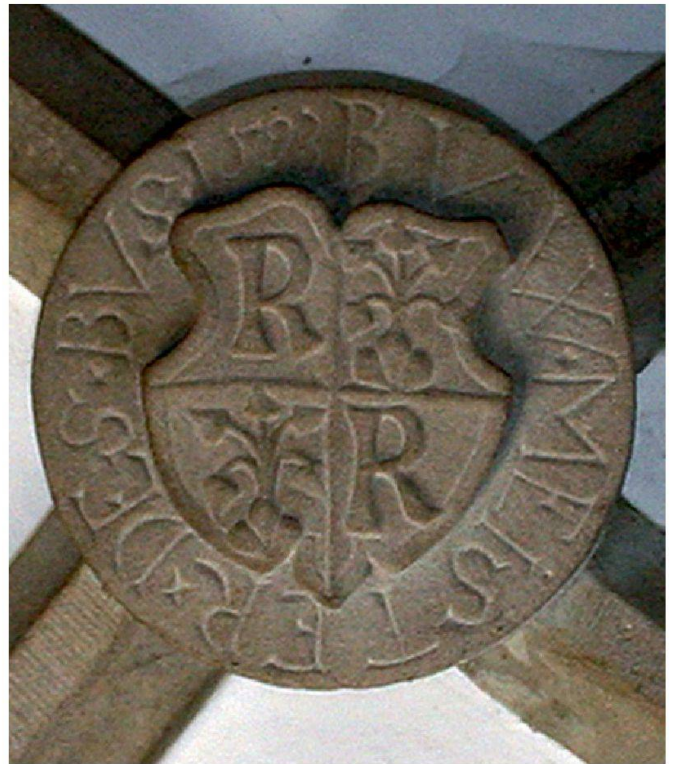
Abb. 9: Schlussstein im Treppenhaus des Rathauses Schwyz. Im Erdgeschoss des Treppenhauses befindet sich im gotischen Kreuzgewölbe ein Schlussstein mit dem Wappen der Reding mit der Umschrift «H(err) • RODOLF • REDIG • RIT(ter) • LANDAMA • V(n)D • P(annerherr) • BVW • MELSTER • DES • BUS • 1593.» Das Treppenhaus aus der zwischen 1591 und 1593 errichteten Vorgängerbaute wurde also in den Neubau nach 1642 integriert.
