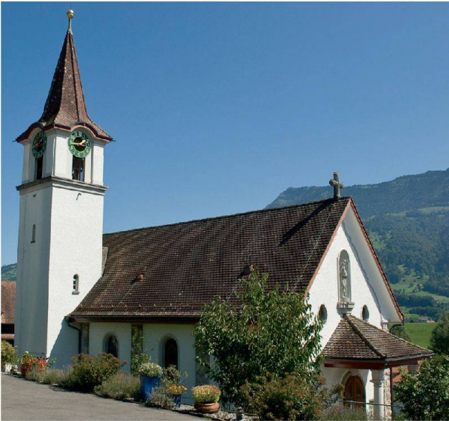
Abb. 6: Merlischachen, Pfarrkirche St. Jakob, erbaut 1925–1926 nach den Plänen von Architekt Arthur Betschon, Baden. Der Neubau ersetzte, wie in Immensee, eine Kapelle aus dem 17. Jahrhundert, die unterhalb der jetzigen Kirche zwischen See und Kantonsstrasse stand.
