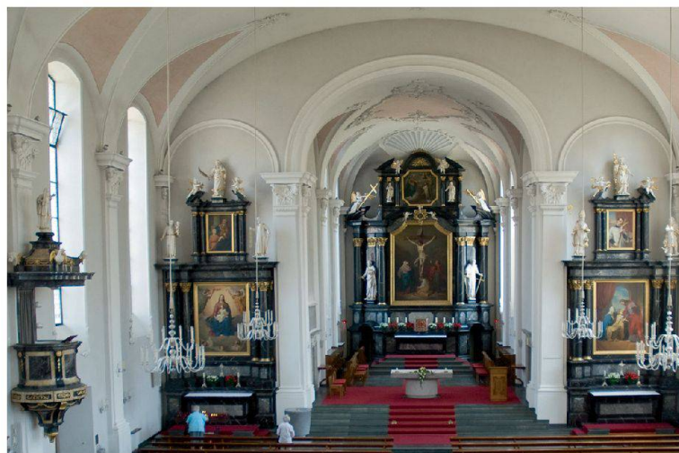
Abb. 2: Küssnacht, Pfarrkirche St. Peter und Paul, Innenansicht nach Osten. Die ursprünglich dreischiffige Halle wurde 1962–1965 in einen einschiffigen Saal umgebaut, indem die Pfeiler, die das Mittelschiff von den Seitenschiffen trennten, abgetragen wurden, eine neue Decke eingezogen und das Kirchenschiff nach Westen um zwei Fensterachsen (Joche) verlängert wurde. Mit dieser Umgestaltung der Kirche wurden zwei Ziele verfolgt, zum einen eine Vereinheitlichung des Raumes und dadurch eine engere Beziehung zwischen dem Volk im Schiff und dem Priester am Altar und zum andern eine Erweiterung des Platzangebotes. Dieser Umbau, der letztlich den Verlust einer stilgeschichtlich interessanten barocken Pfeilerhalle bedeutet, wird heute allgemein bedauert.
