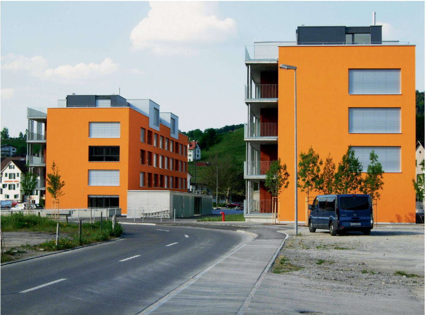
Das Sagiareal in Wangen mit modernen Mehrfamilienhäusern.
