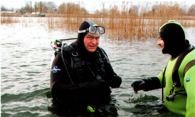
Abb. 38: Besuch der Taucharbeiten am Seedamm durch den Schwyzer Regierungsrat Dr. Georg Hess bei winterlichen, kalten Bedingungen.
