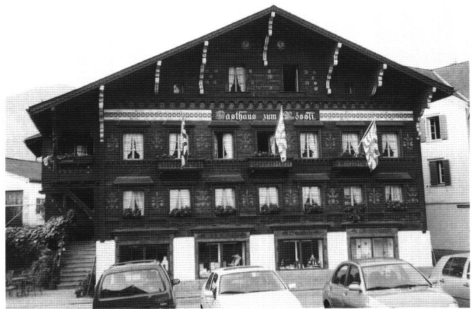
Abb. 9: Steinen, Gasthaus zum Rössli. Das von einem Berner Oberländer Chalet inspirierte Gasthaus dominiert den südlichen Abschluss des Dorfplatzes.
