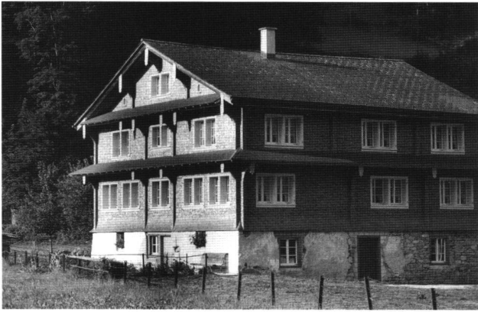
Abb. 7: Muotathal, Haus Büchsenen. Das Bauernhaus gehört zu den späten Vertretern mit flachgeneigtem sogenanntem Tätschdach, das auf eine Deckung mit Holzschindeln hinweist.
