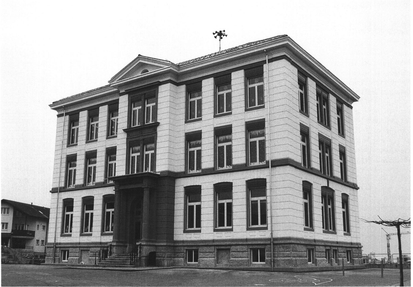
Abb. 21: Wollerau, Altes Schulhaus. Die durchgehende Quadrierung beim Verputz wurde anhand alter Photographien wiederhergestellt. Dadurch lehnt sich der Bau stark an Bauten des deutschen Klassizismus an.
