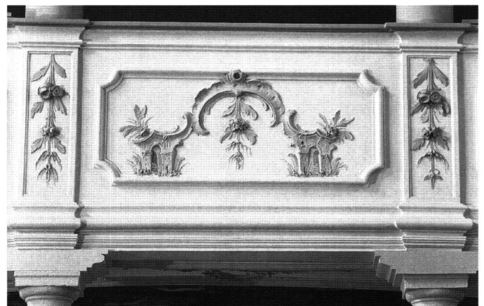
Abb. 2: Muotathal, Pfarrkirche St. Sigismund und Walpurga. Die in Rocaille auslaufenden Architekturelemente, die keine bestimmte Architektur wiedergeben wollen, sind beliebte Motive des Spätbarock.
