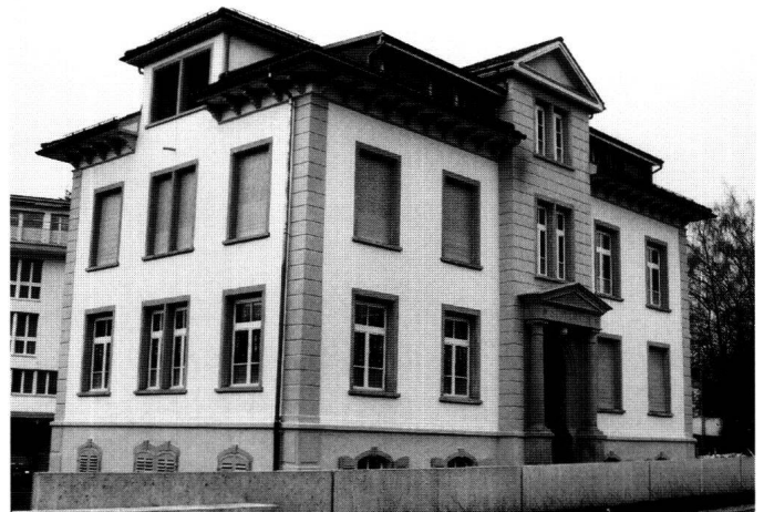
Abb. 2: Schwyz: Altes Schulhaus, Ibach. Der dunkler herausgehobene Mittelrisalit mit dem vorgelagerten Portikus sowie die von Konsolen getragene Dachuntersicht sind typische Motive des Schulhausbaues im 19. Jahrhundert.
