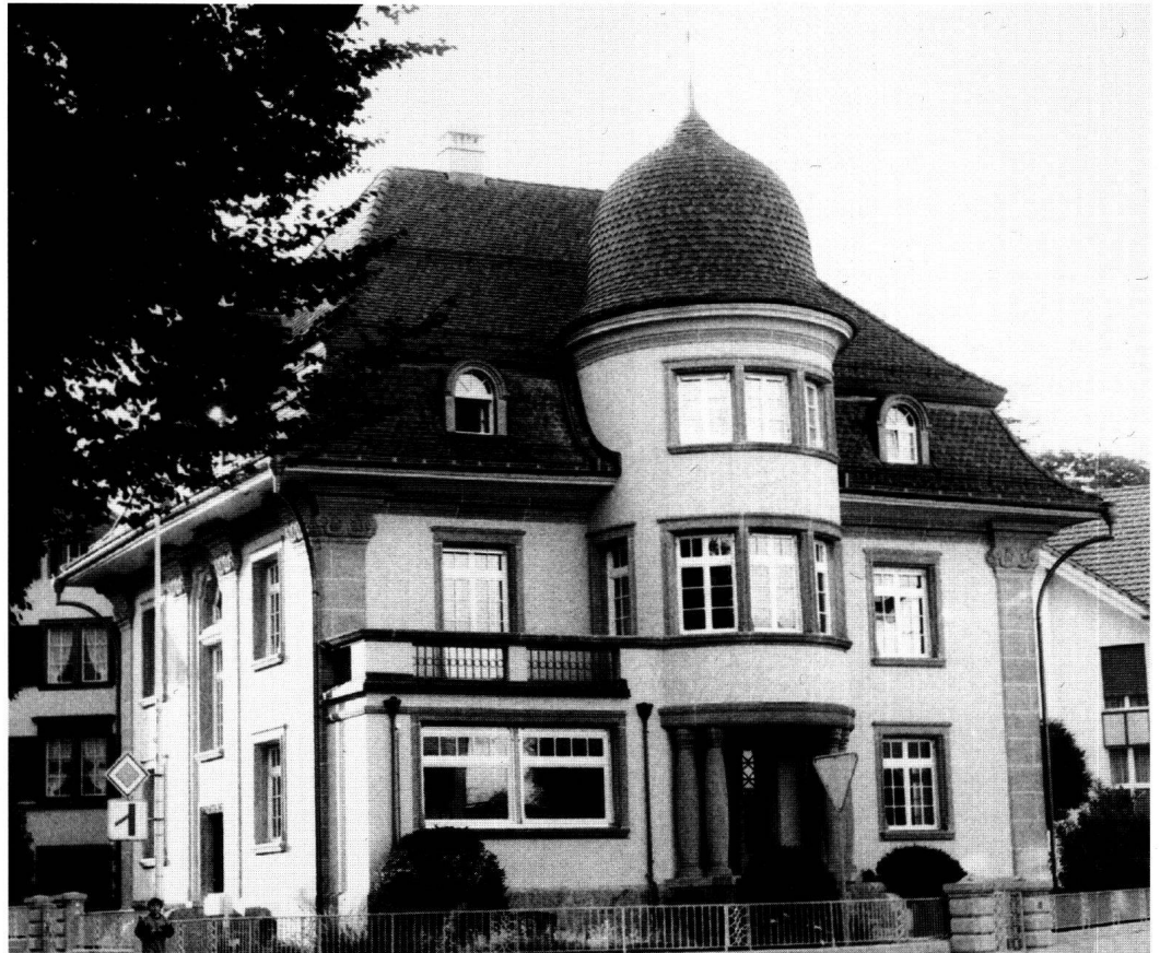
Abb. 20: Lachen: Schwesternhaus, mittlere Bahnhofstrasse 1. Die Hauptfront der ehemaligen Fabrikantenvilla wird durch den runden, vorgebauten Erker mit geschweiften Dachhaube dominiert. Kombiniert sind traditionelle Elemente wie das Mansarddach und moderne Art-Deco-Elemente.
