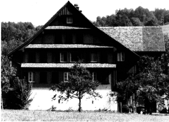
Abb. 16: Sattel: Haus Eumatt, Jansernstrasse 26. Im 19. Jahrhundert wurden die ursprünglichen Reihfenster zu Gunsten von Einzelfenstern mit Jalousieläden aufgegeben.
