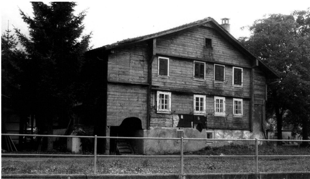
Abb. 3: Schwyz: Haus am Landsgemeindeplatz, Hinteribach – heute im Freilichtmuseum Ballenberg. Zuletzt präsentierte sich das mittelalterliche Haus mit einer Bretterverkleidung des 20. Jahrhunderts. An der linken Hausecke erkennt man unter einer Schicht aus Dachpappe und einem Schindelschirm das originale Holz.
