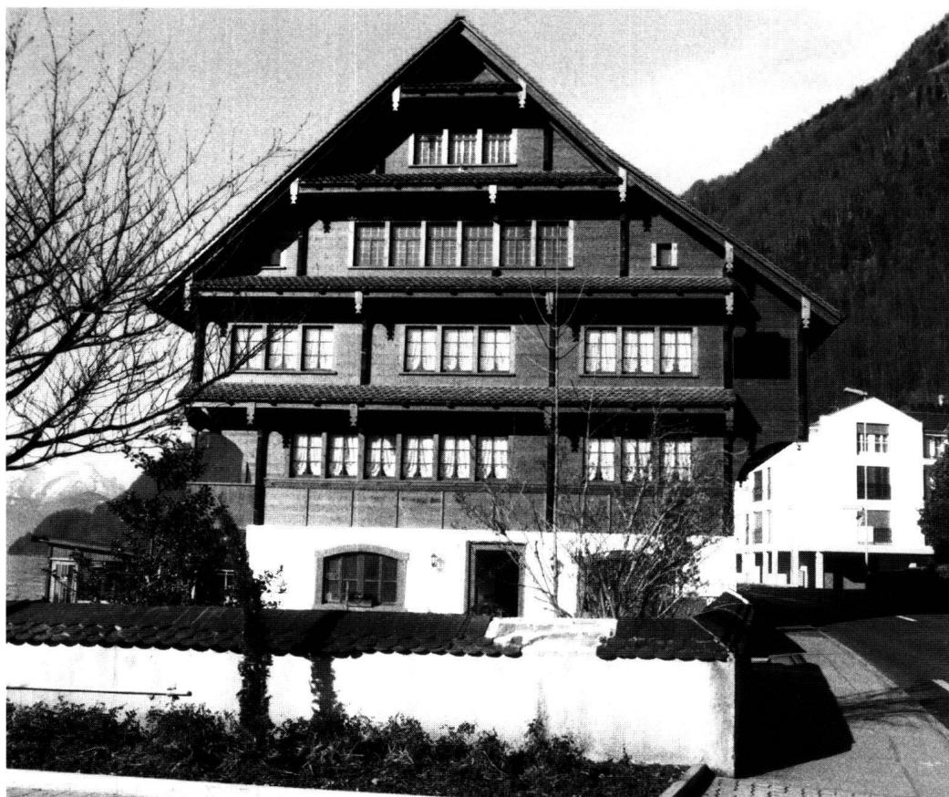
Abb. 19: Gersau: Haus Gerbi. Nach dem Brand von 1994 wurde der wuchtige Baukörper anhand photogrammetrischer Aufnahmen wiederhergestellt.
