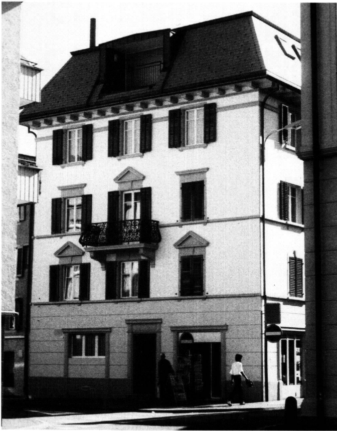
Abb. 21: Lachen: Haus Storchen St. Gallerstrasse 2. Im Kern des Storchen verbirgt sich ein spätgotisches Giebelhaus. Dieses wurde im 19. Jahrhundert durch Aufbauten und Fassadenveränderungen zu einem typischen Geschäftshaus.
