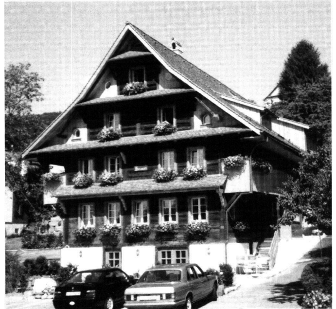
Abb. 32: Küssnacht: Haus Husmatt, Luzernerstrasse 206, Merlischachen. Das Wohnhaus Husmatt gehört zu den wenigen konsequent ausgebildeten Ständerbauten im Bezirk Küssnacht.
