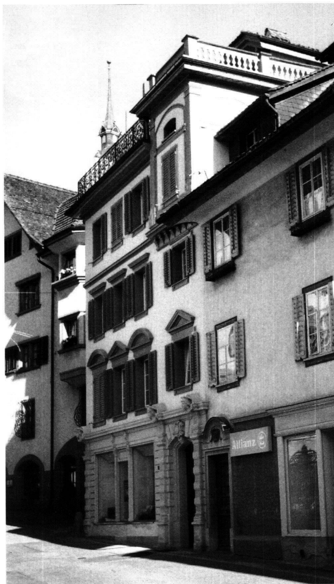
Abb. 11: Schwyz: Haus Dusser, Strehlgasse. Unter der reichen Fassadendekoration des 19. Jahrhunderts verbirgt sich ein Fachwerkbau, der unmittelbar nach dem Dorfbrand von 1642 entstanden sein dürfte.
