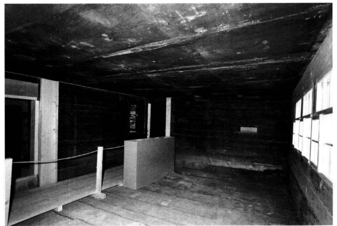
Abb. 7: Schwyz: Haus am Landsgemeindeplatz, Hinteribach – heute im Freilichtmuseum Ballenberg. Wohnraum. Die dicken Bohlen dienen zugleich als Boden und Decke. Im Hintergrund sind eine originale Fensterlücke sowie die Öffnung des Wandkastens zu erkennen.
