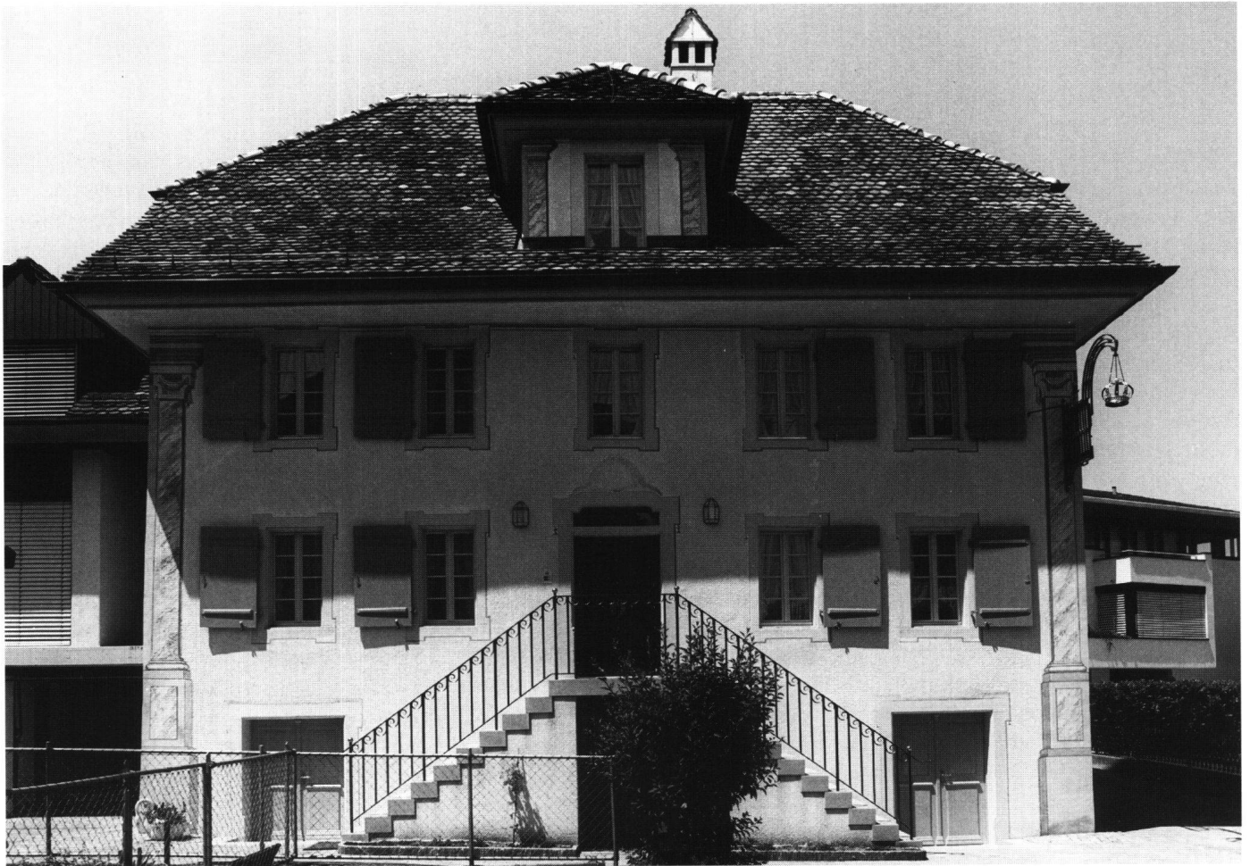
Abb. 7: Altendorf, Krone, Seestatt. Die strenge Gliederung des Baukörpers wird durch die Architekturbemalung unterstrichen. Originell ist die axial-symmetrische Anordnung der Fensterläden.
