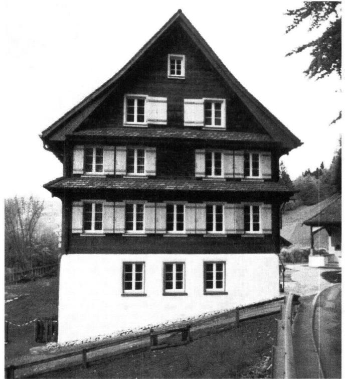
Abb. 13: Sattel, Haus Schornen, Weiermattli (Morgartenhaus). Das gewandete Gebäude besitzt die Merkmale des Bauernhauses um 1800. An die Stelle von Lauben sind umlaufende Klebdächer getreten. Hingegen ist der barocke Dachknick beibehalten worden. Der Keller besitzt für die Bauzeit erstaunlich grosse Fenster.
