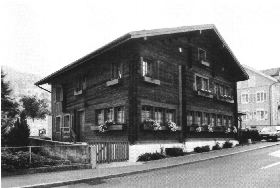
Abb. 9: Steinen, Haus Schürmann, Schwyzerstrasse 9. Das Gebäude präsentiert sich heute in der Kombination des Kernbaus aus dem 13. Jahrhundert und dem westseitigen Anbau aus dem 18. Jahrhundert. Rückseitig sind die Neubauteile in Ständerkonstruktion zu erkennen.
