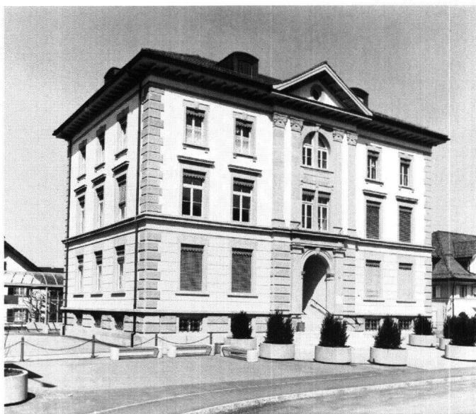
Abb. 18: Schübelbach, Schulhaus Siebnen. Das Gebäude besitzt die typischen Merkmale von Schulhausbauten aus dem 19. Jahrhundert. Für Lehranstalten wurde gerne ein repräsentativer Renaissancestil angewandt.
