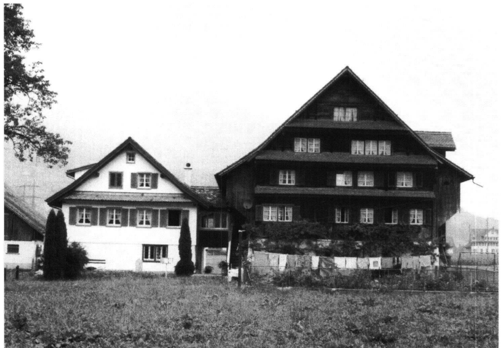
Abb. 4: Ingenbohl, Ökonomiegebäude zum Bauernhaus Feldweg 21, Feld. Das während längerer Zeit unbenutzte Trotten- und Käseriegebäude dient nach der Restaurierung als Wohnhaus.
