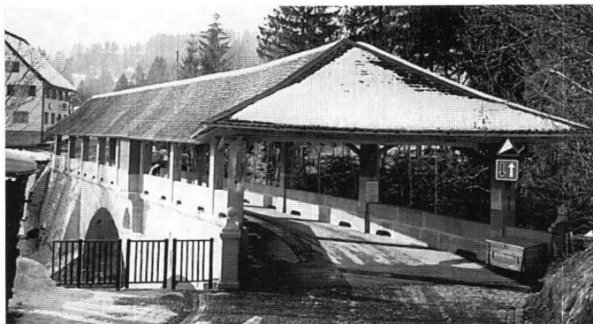
Abb. 22: «Tüüfelsbrugg» am Etzel.
