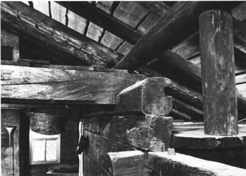
Blick vom oberen Gang gegen die Dachuntersicht. Grundlage des Dachaufbaues bilden unabgekantete Bretter, auf denen ursprünglich direkt die Brettschindeln lagen.
