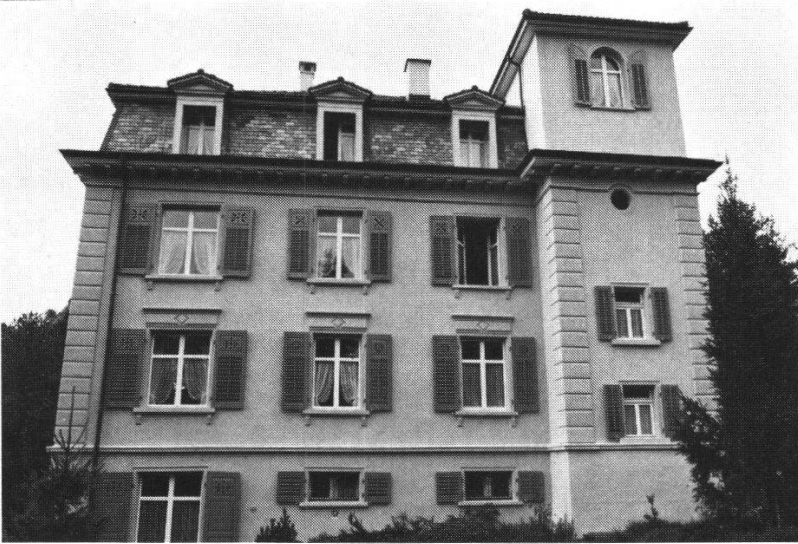
Schwyz, Villa Landtwing nach der Restaurierung. Durch die Rekonstruktion der dekorativen Elemente wie Eckquader, Dachkonsolen und Fensterbekrönungen hat das Gebäude seinen architektonischen Halt wieder erlangt.
