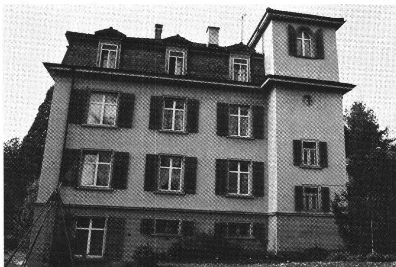
Schwyz, Villa Landtwing, Bahnhofstraße, vor der Restaurierung. Durch das Abräumen aller dekorativen Elemente verlor das Haus seinen prägnanten Charakter vollständig.
