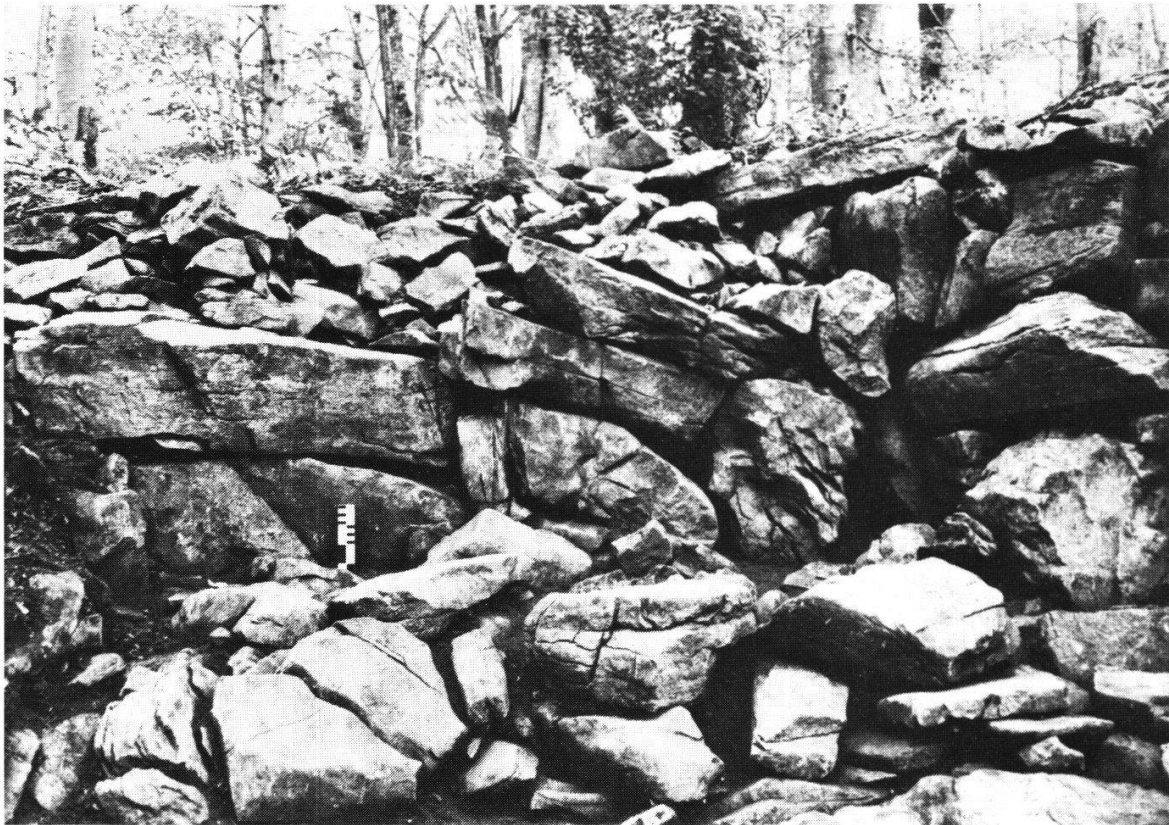
Illgau/Balmis 1987, Gebäude 2, östliche Innenecke, Ansicht von Westen.
