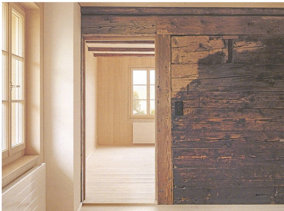
Abb. 10: Schindlerhof, Bestehende Bohlenständerwand zwischen den Zimmern im zweiten Wohngeschoss, Foto: Haupt Holzbauarchitektur, Ruswil.
