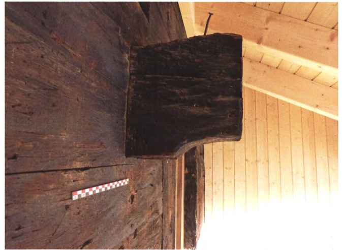
Abb. 5: Schwyz/Ibach, Oberschönenbuch 46. Westfassade, zweites Wohngeschoss. Einzelvorstoss, an der Unterkante profiliert mit Kehle.
