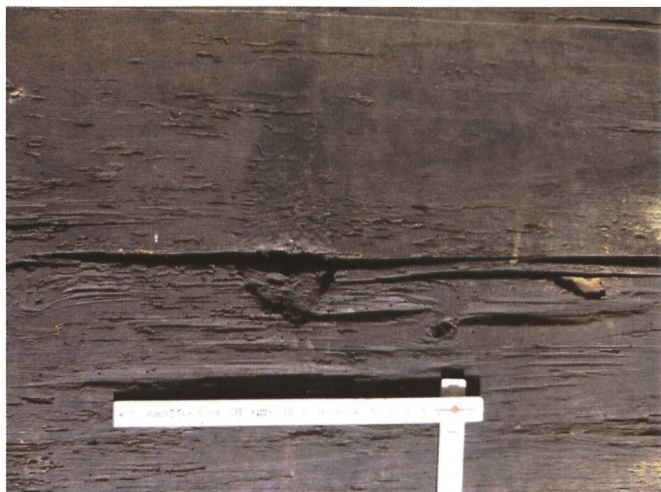
Abb. 14: Schwyz/Ibach, Oberschönenbuch 46. Nordost-Kammer im zweiten Wohngeschoss. Flämmchenförmige Einbrennspur.
