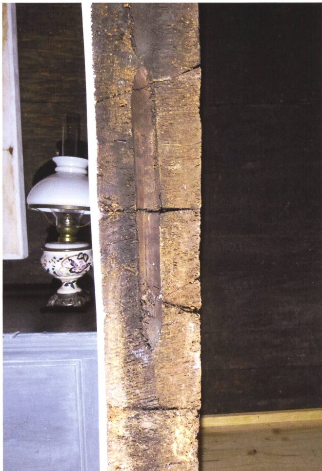
Abb. 8: Schwyz/Ibach, Oberschönenbuch 46. Zweites Wohngeschoss. Konkav gehobelte Auflageflächen der Vierkantbalken, nur die Kanten kommen aufeinander zu liegen. Im nachträglichen Wandeinschnitt sind ferner die Negative der Holzdübel zu erkennen.
