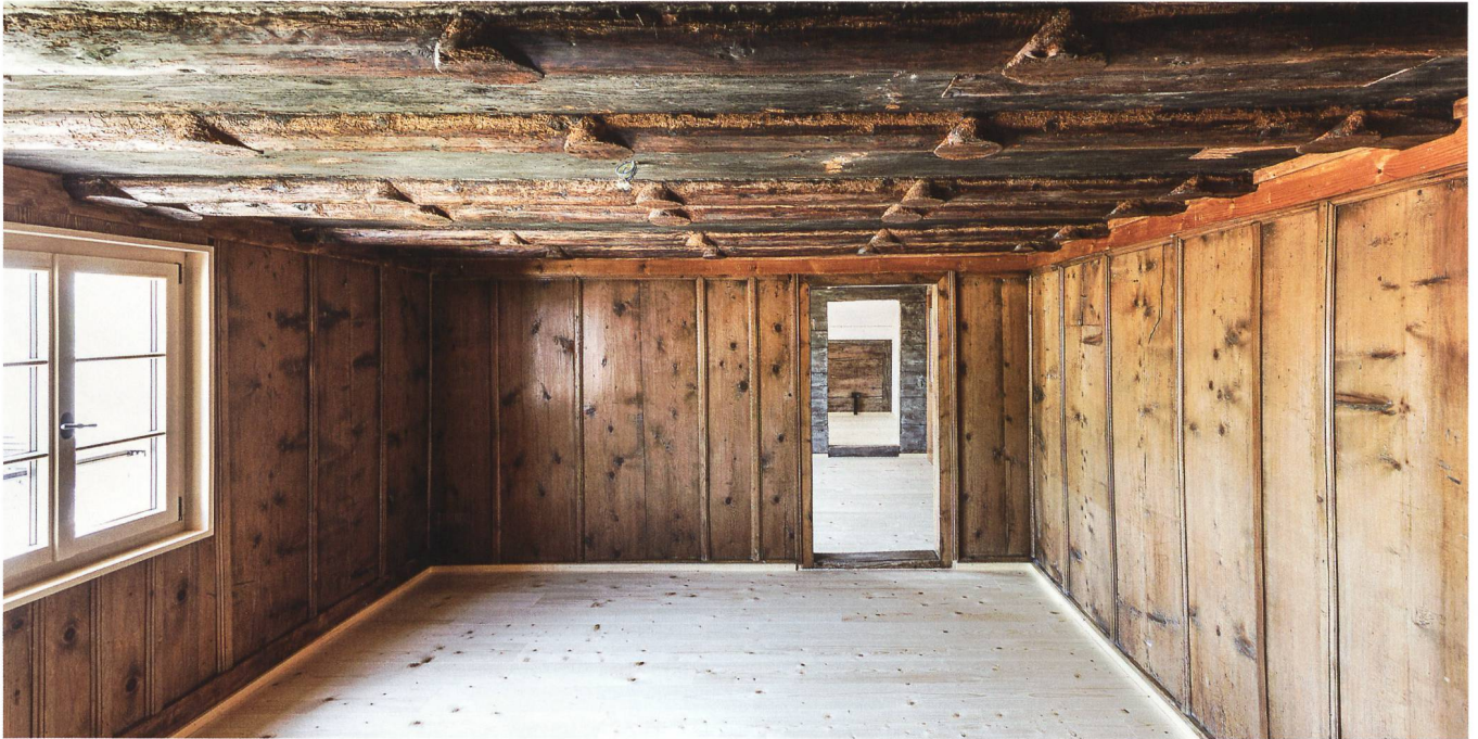
Abb. 23: 2. Obergeschoss, Kammer im Vorderhaus mit Bohlen-Balken-Decke und verkleideten Blockwänden. Foto: Regine Giesecke, Zug, 2022.
