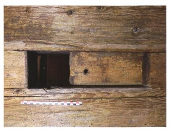
Abb. 4: Schwyz/Ibach, Oberschönenbuch 46. Südfassade, zweites Wohngeschoss. Lukenfenster, verschliessbar durch einen Holzladen, der zwingend während des Bauvorganges in die eingeschnittene Nut eingesetzt worden ist.
