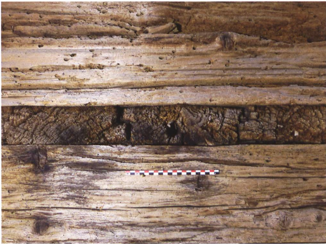
Abb. 6: Schwyz/Ibach, Oberschönenbuch 46. Südfassade, zweites Wohngeschoss. Wanddurchstossende Decken-/Bodenbohlen.
