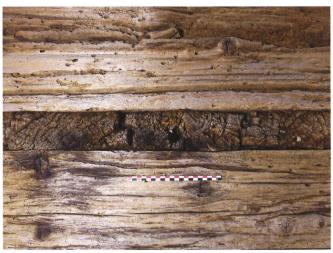
Abb. 6: Schwyz/Ibach, Oberschönenbuch 46. Südfassade, zweites Wohngeschoss. Wanddurchstossende Decken-/Bodenbohlen.
