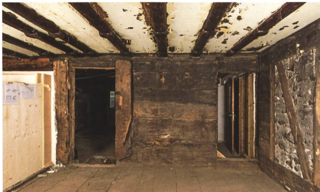
Abb. 9: Schwyz/Ibach, Oberschönenbuch 46. Erstes Wohngeschoss, grosse Stube. Bohlen-Balken-Decke. Die Deckenbohlen waren zur Isolation mit Auslegeware beklebt, deren Reste noch zu sehen sind.
