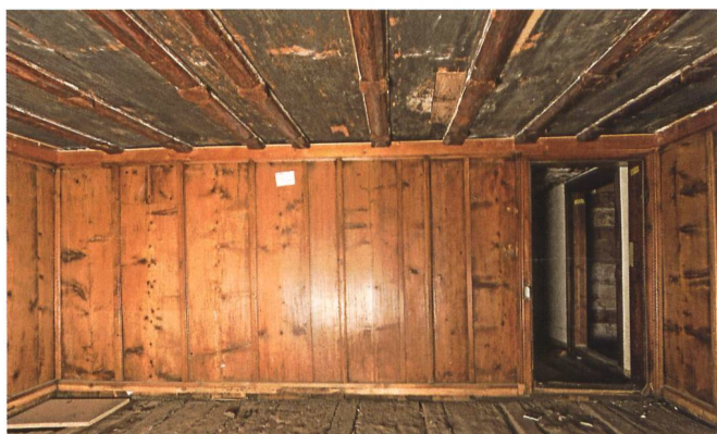
Abb. 10: Schwyz/Ibach, Oberschönenbuch 46. Zweites Wohngeschoss, nordwestliche Kammer. Bohlen-Balken-Decke und Boden (entsprechend der Bohlen-Balken-Decke der grossen Stube) aus der Bauzeit, das Täfer stammt aus dem 18. Jahrhundert.
