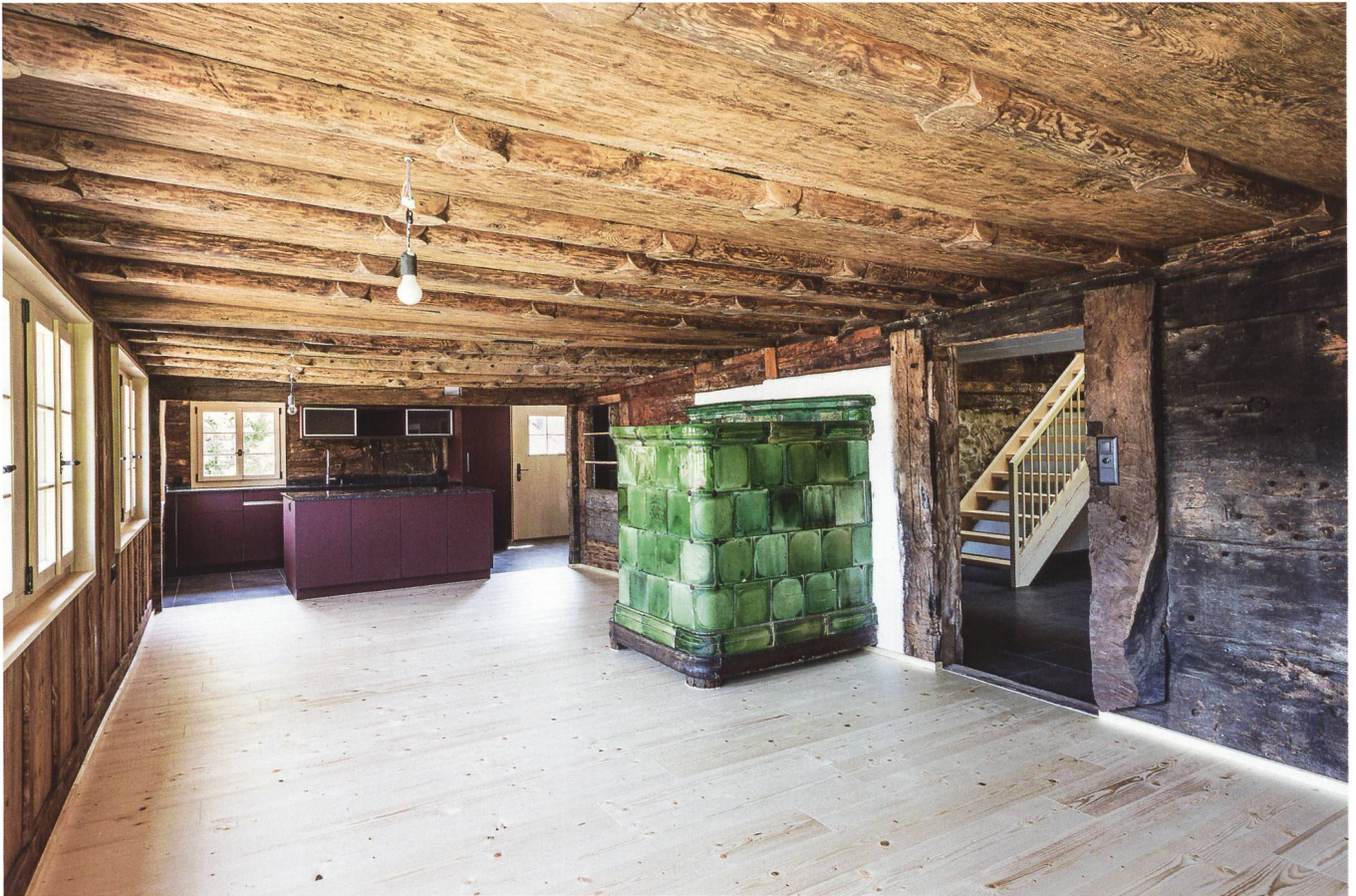
Abb. 21: 1. Wohngeschoss, Stube mit Kachelofen, Bohlen-Balken-Decke und Küche im Hintergrund. Foto: Regine Giesecke, Zug, 2022.
