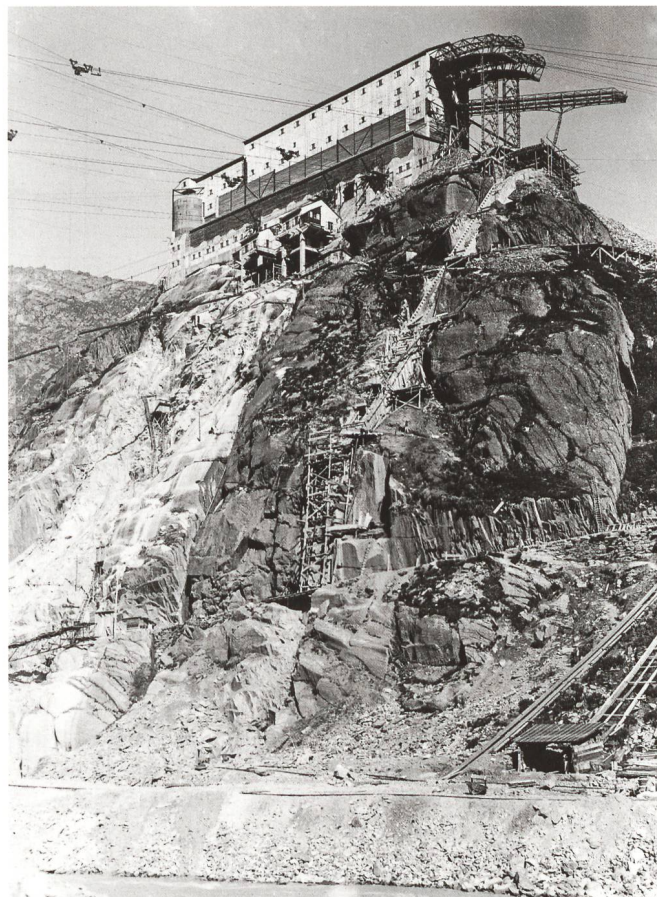
Abb. 5: Aufbereitungsanlage für die Staumauer in der Schräh ca. 1923. Hier wurde Sand und Kies zur Herstellung von Zement verarbeitet.
