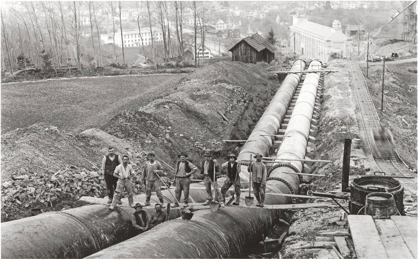
Abb. 4: Neun Arbeiter unterbrechen ihre Arbeit an der Druckleitung, um für den Fotografen Modell zu stehen. Im Hintergrund ist das Kraftwerk Rempen zu sehen. Im Hintergrund ist das Maschinenhaus Siebnen zu sehen.
