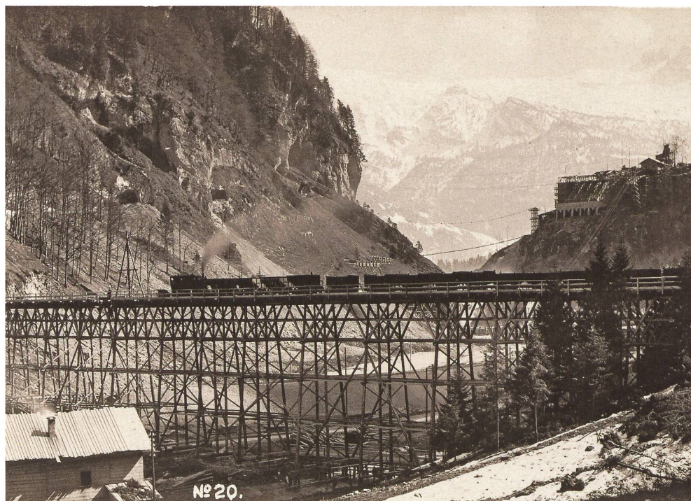
Abb. 9: Materialbahn auf einer Baustelle des Kraftwerks.
