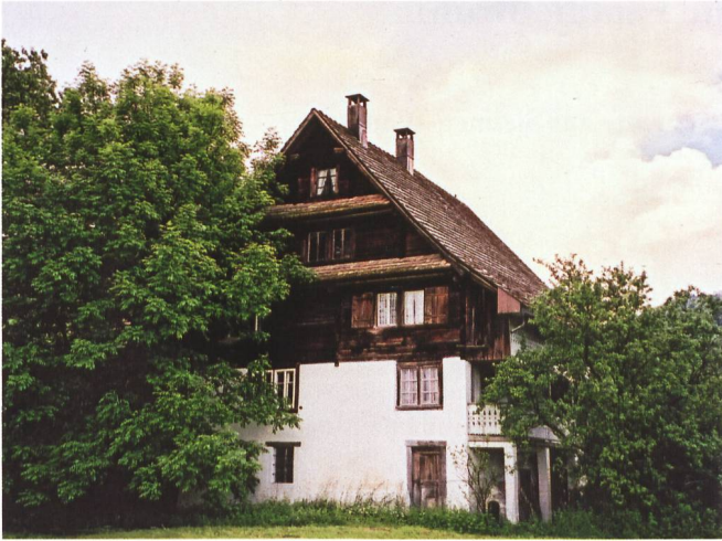
Abb. 1: Der im 18. Jahrhundert erbaute Widenhof der Familie Bruhin im Jahr 2005. Auf der Nordseite sichtbar sind die originalen Klebdächer oberhalb der Fenster sowie die weisse Sockelmauer.
