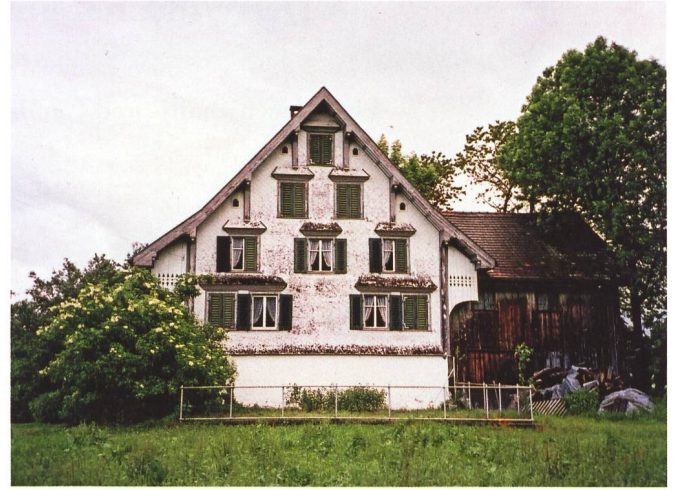
Abb. 2: Die südliche Schindelfassade des Widenhofs erhielt eine weisse Tünchung, 2005.
