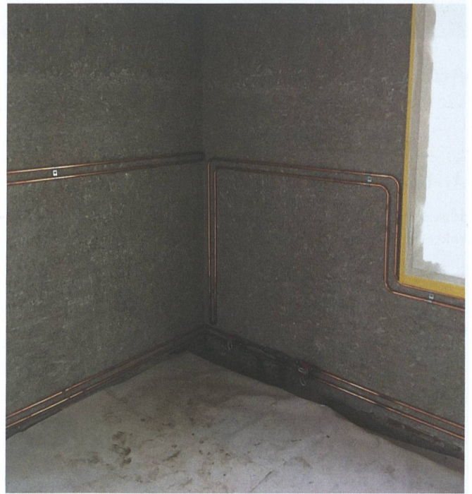
Abb. 4: Schwyz, Palais Kyd, Kappel-matt, Ökonomiegebäude: Innenauf-nahme Erdgeschoss während der Restaurierung: Kupferrohre der Wand-heizung im Brüstungsbereich.
