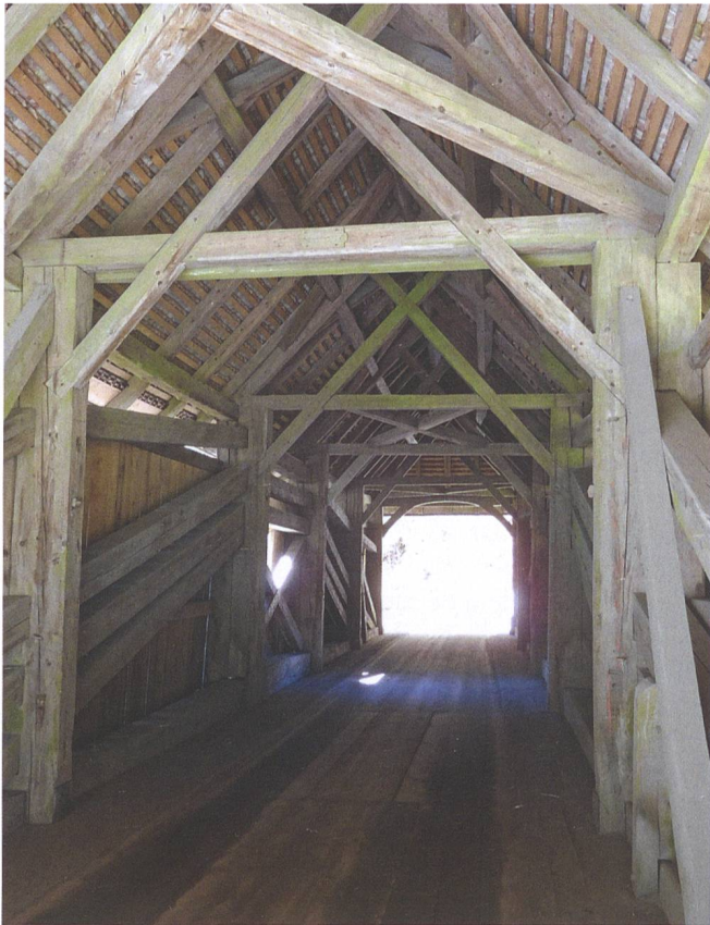
Abb. 3: Blick in die 2011 restaurierte Suworow-Brücke mit der Holzkonstruktion von 1810.
