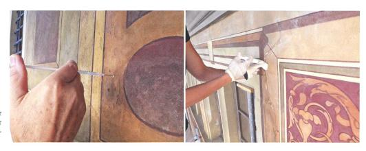
Abb. 1 a+b: Rathaus Schwyz. Bei der Restaurierung werden Injektionen zur Sicherung des Maluntergrundes angebracht.
