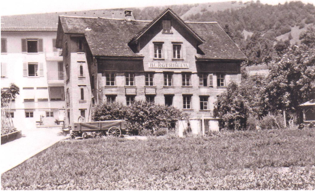
Abb. 3: Das Bürgerheim auf der Liegenschaft «Ebnetmelken» wurde 1848 als Armenhaus eingerichtet und 1871 vergrössert.
