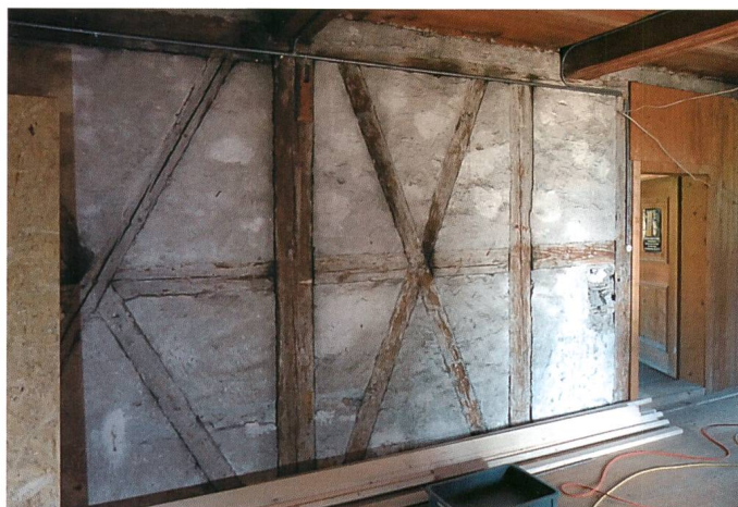
Abb. 14: Erstes Geschoss des Dachraumes, nördliche Kammer, Südwand in Fachwerktechnik (1710d), Blick gegen Norden.
