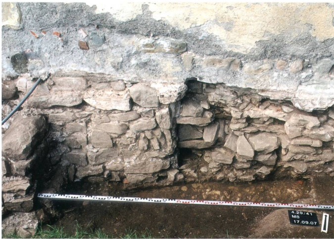
Abb. 24: Freienbach, Ufnau, St. Peter und Paul, 2007, Fundament der Südmauer M8 des Kirchenschiffs, von Süden. Es ist ein satt vermörtelter, in die Lücke zwischen den beiden nachrömischen Mauern M36 (links) und M39 (rechts) eingefügter Fundamentabschnitt (1).
