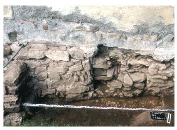
Abb. 24: Freienbach, Ufnau, St. Peter und Paul, 2007, Fundament der Südmauer M8 des Kirchenschiffs, von Süden. Es ist ein satt vermörtelter, in die Lücke zwischen den beiden nachrömischen Mauern M36 (links) und M39 (rechts) eingefügter Fundamentabschnitt (1).
