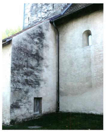
Abb. 18: Freienbach, Ufnau, St. Peter und Paul, 2007, Ecke Beinhaus/ Schiff, Beinhaus mit Pforte in der Westmauer. Der Umriss des 1958 abgebrochenen nördlichen Querschiffs zeichnet sich in den Putzoberflächen von Beinhaus und Schiff auf dieser Foto von 2018 deutlich ab.
