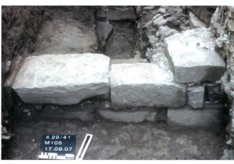
Abb. 26: Freienbach, Ufnau, St. Peter und Paul, 2007, Mauer M105, von Norden, nördliche Front aus sauber gefügten Sandsteinquadern.
